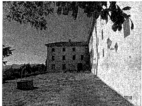
Ex fabb. agricoli lato sud e parte della villa
