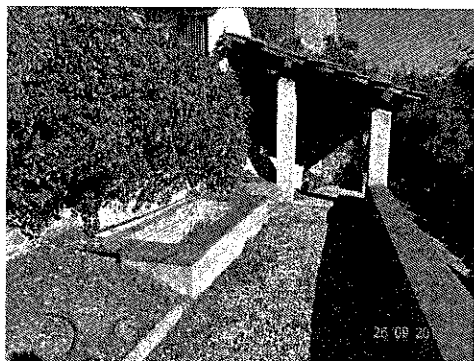
tettoia e lavatoio
