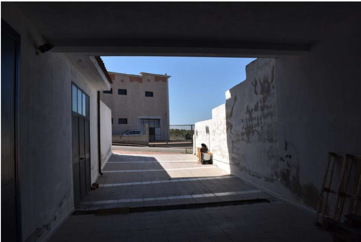
Foto n. 6– Ingresso al piano seminterrato – lotto n.1
