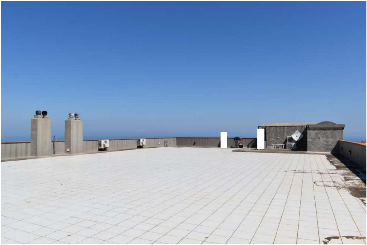
Foto n. 25– lastrico solare - lotto n.3
