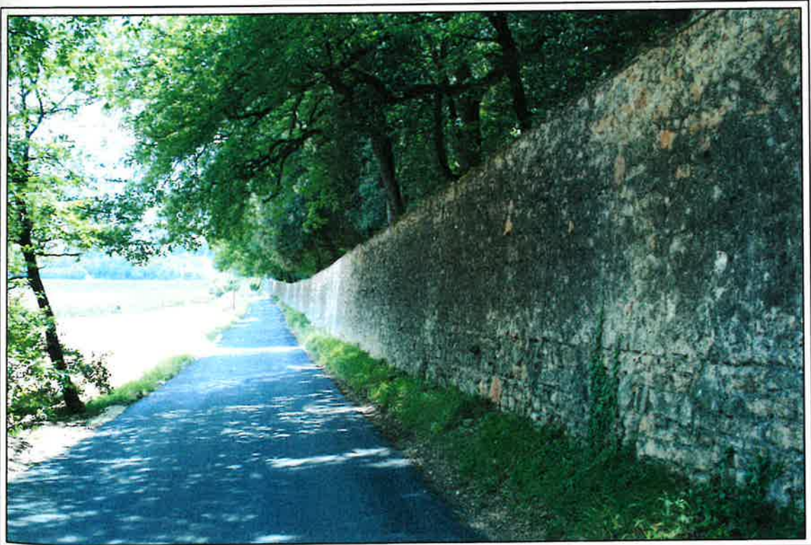
Foto n°12 Vista Muro di Cinta
