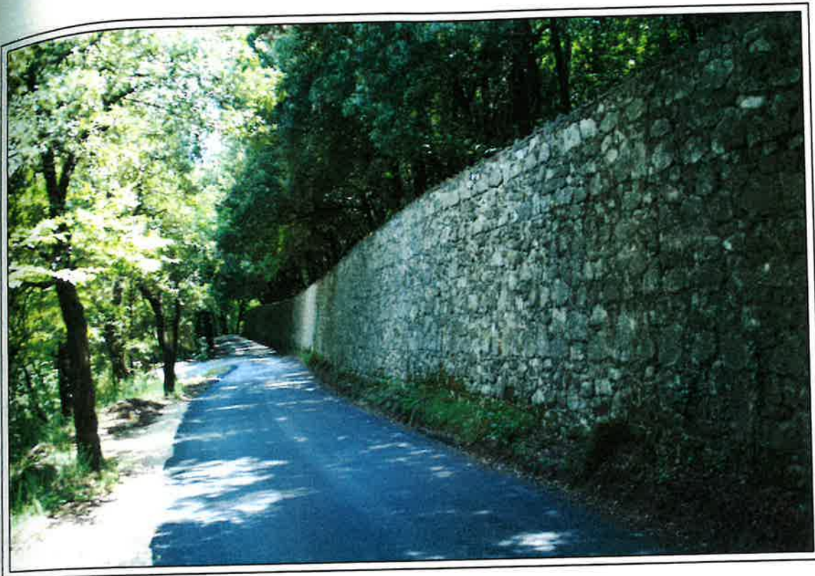
Foto n°13 Vista Muro di Cinta
