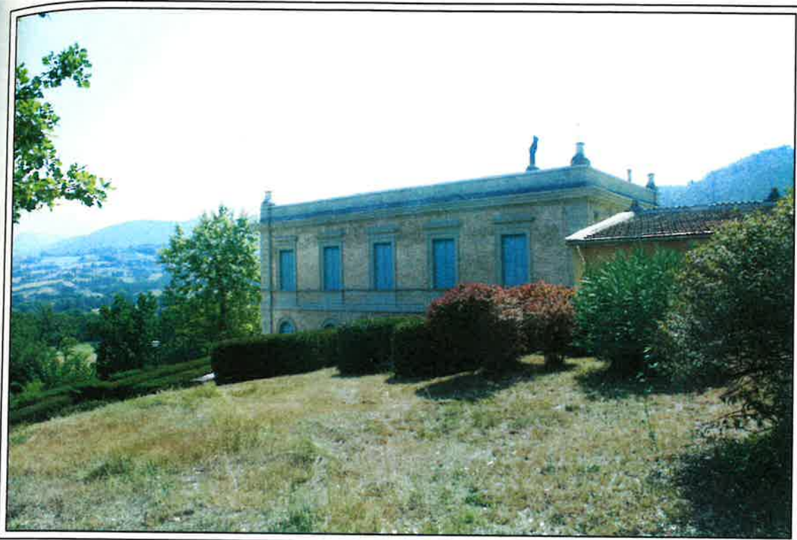
Foto n°3 Vista Prospetto Nord
