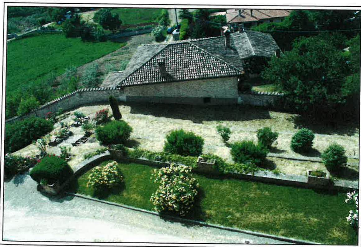
Foto n°4 Vista Giardino Lato Sud
