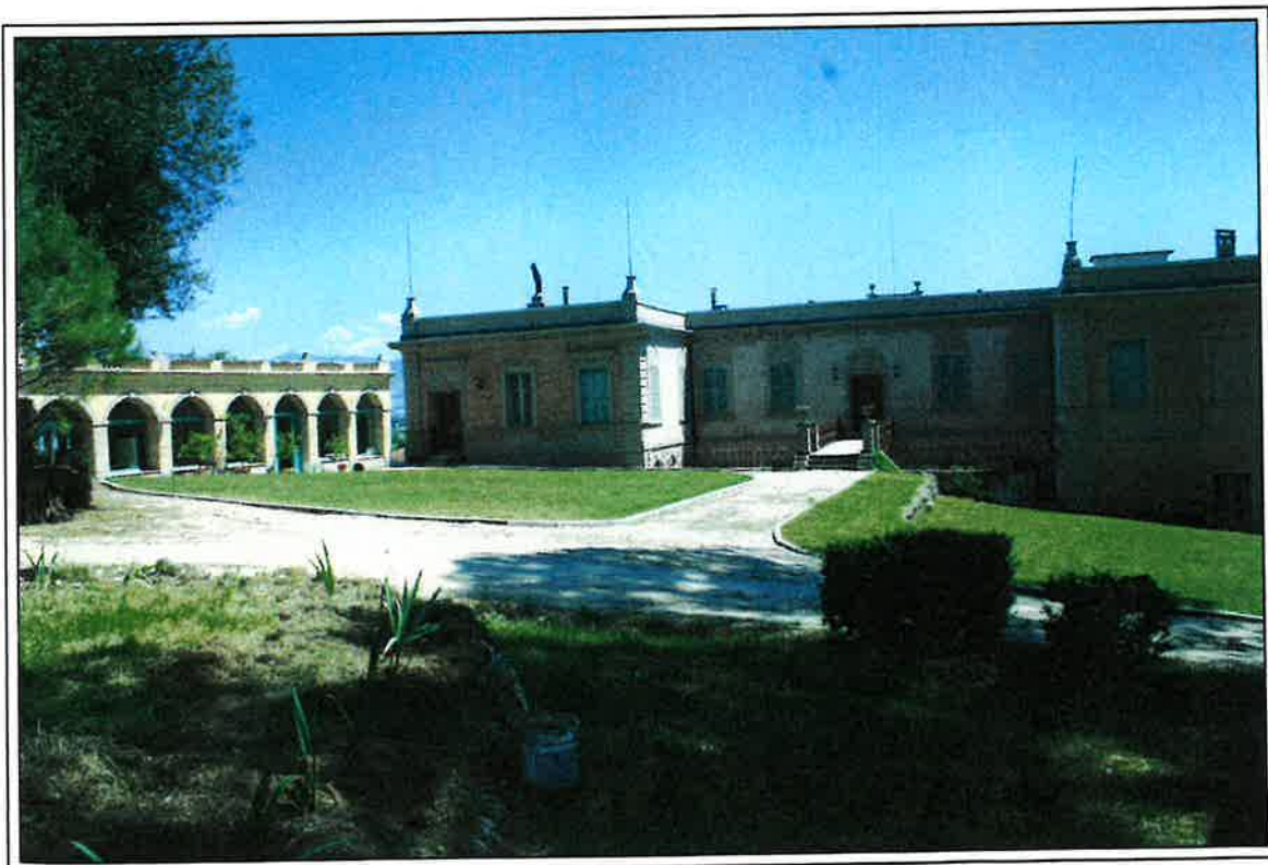
Foto n°2 Vista Prospetto Ovest
