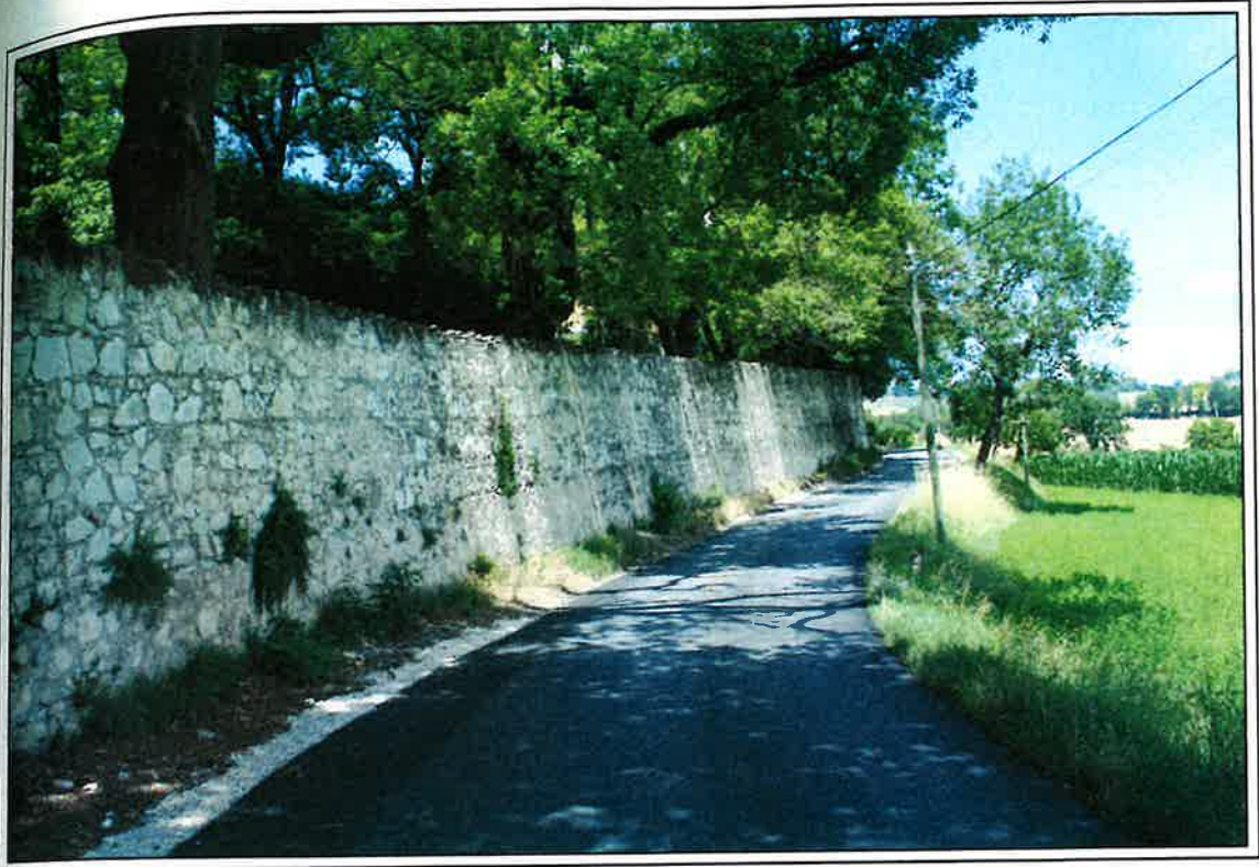
Foto n°11 Vista Muro di Cinta
