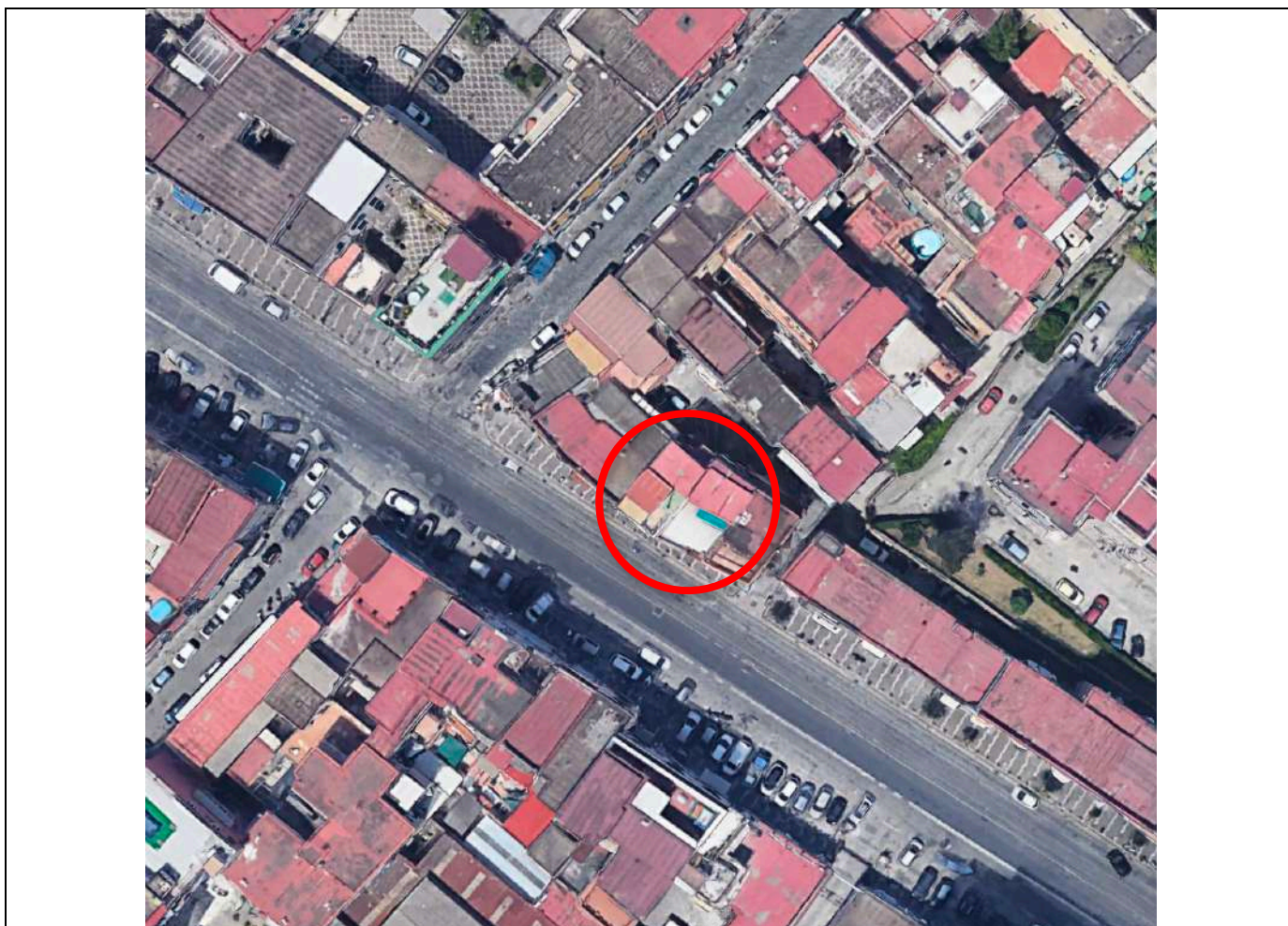
Foto 1: vista satellitare - Fabbricato sito in Napoli, in “Vico Catari n. 108”.
