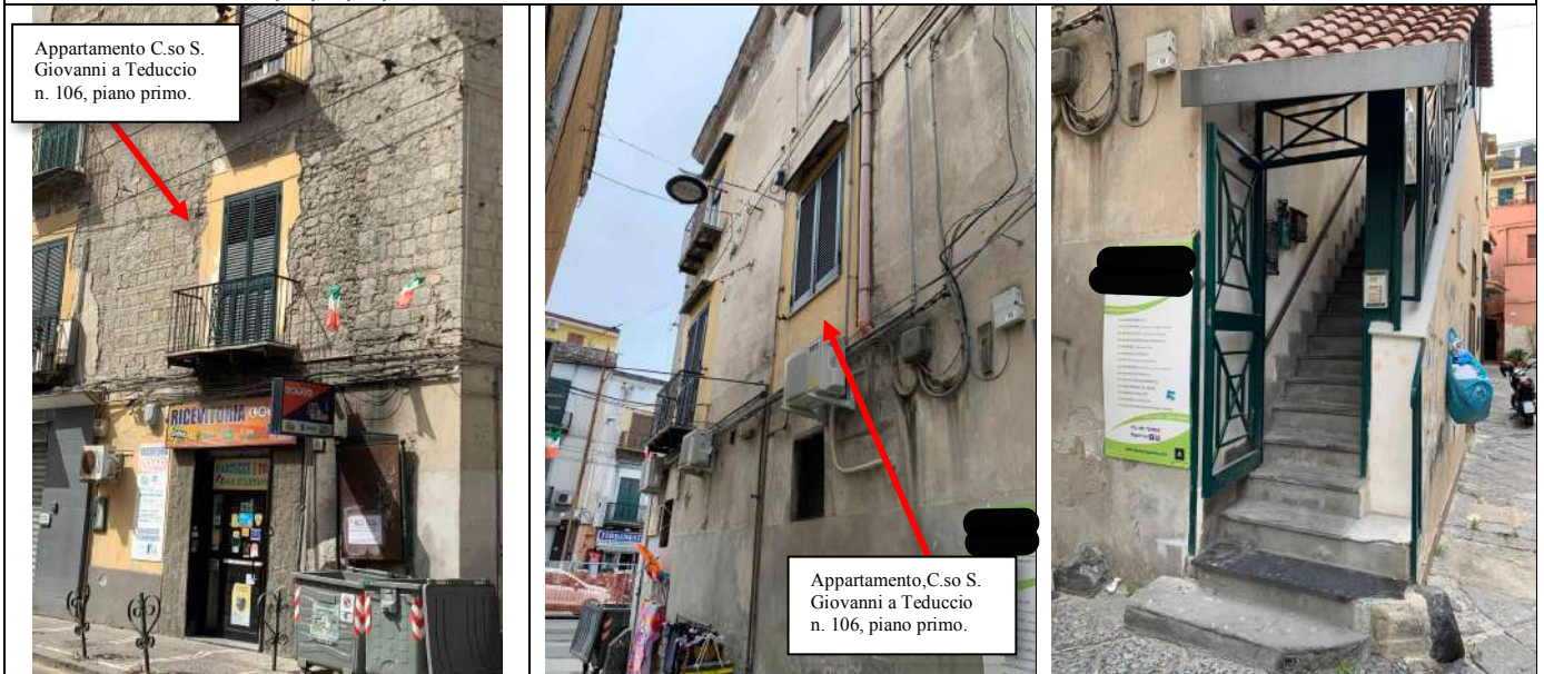
Foto 9, 10, 11: viste fabbricato da C.so S. Giovanni e da Vico Catari; portone ingresso civ. 106
