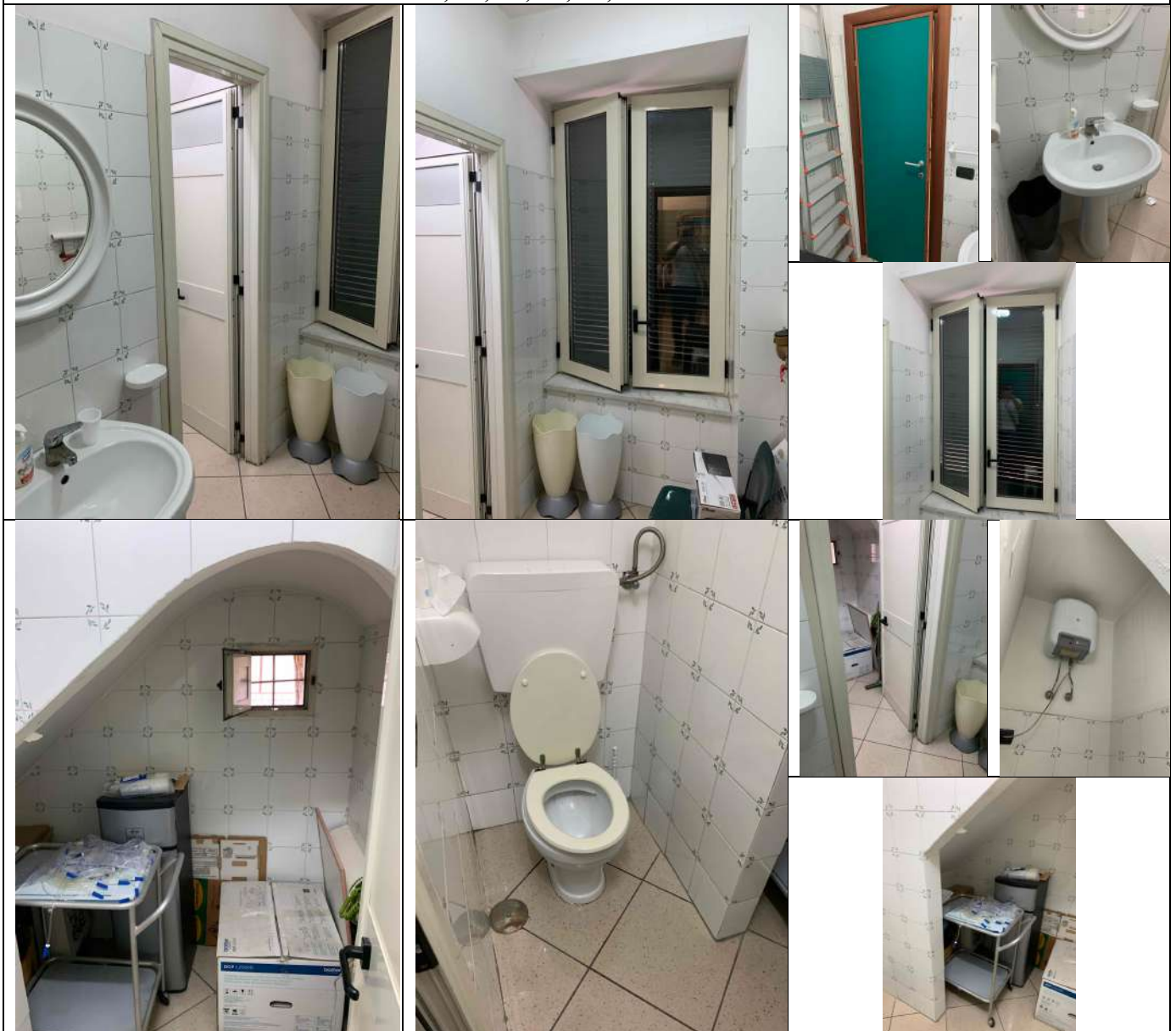
Foto da 42 a 51: viste W.C. con antibagno
