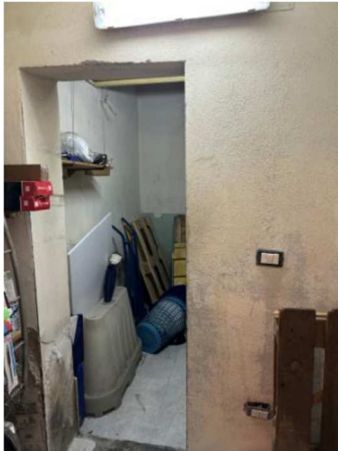
Foto n. 19 – Disimpegno – verso il retrobottega
