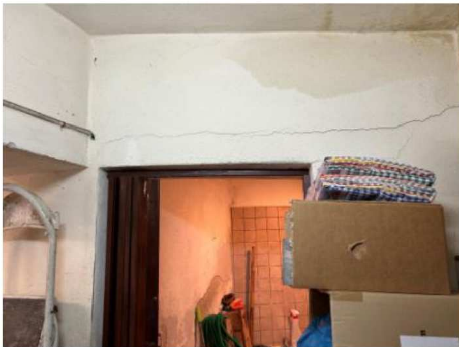
Foto n. 20 – Disimpegno – verso il bagno
