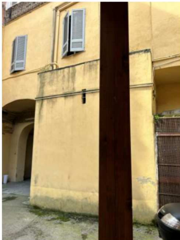
Foto n. 4 – Immobile pignorato – vista dal cortile comune
