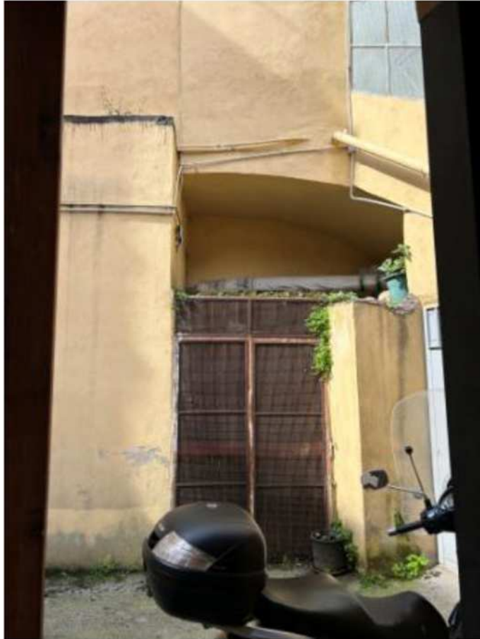
Foto n. 3 – Immobile pignorato – vista dal cortile comune
