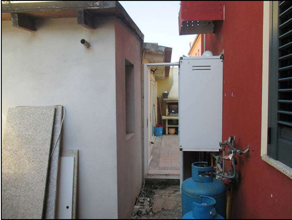
Vista sul retro dell'edificio.
