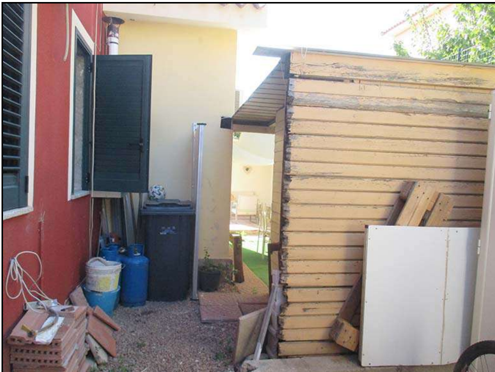
Vista sul retro dell'edificio.
