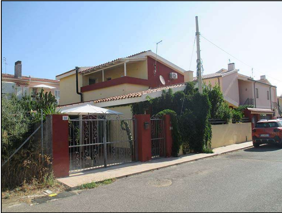
Vista dell'immobile da via Santorre di Santarosa.
