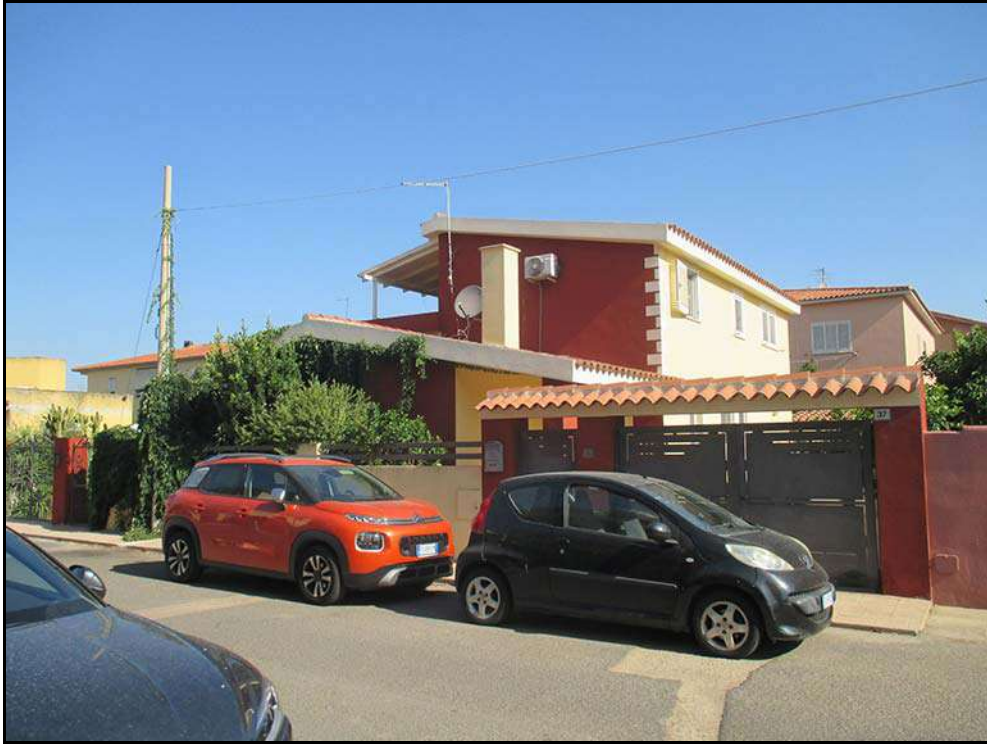
Vista dell'immobile da via Santorre di Santarosa.
