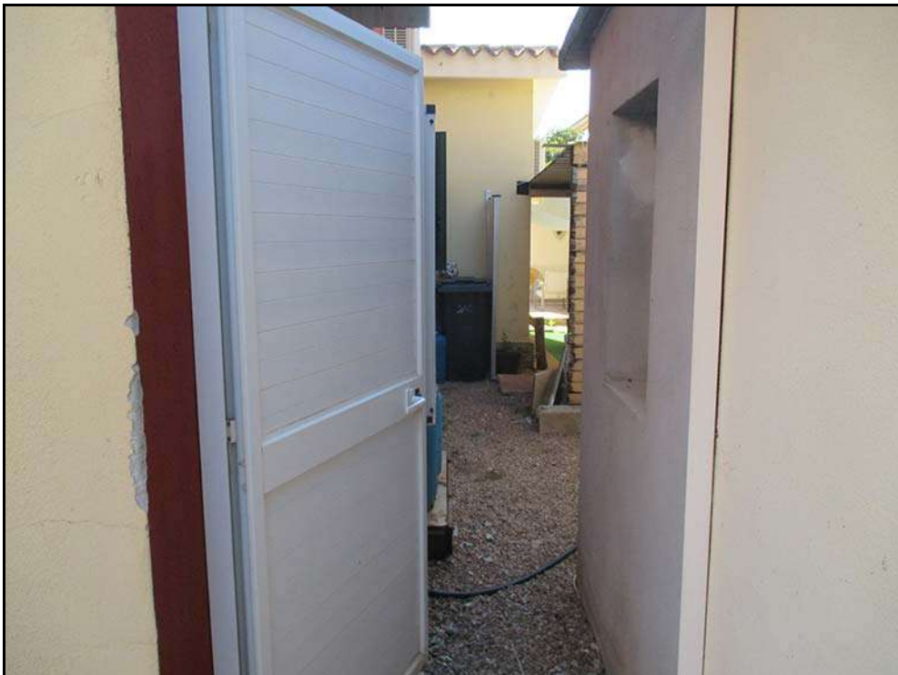
Vista sul retro dell'edificio.
