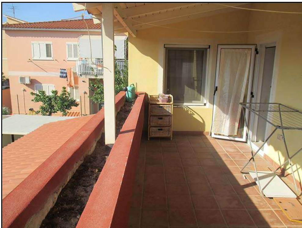
Vista della veranda.
