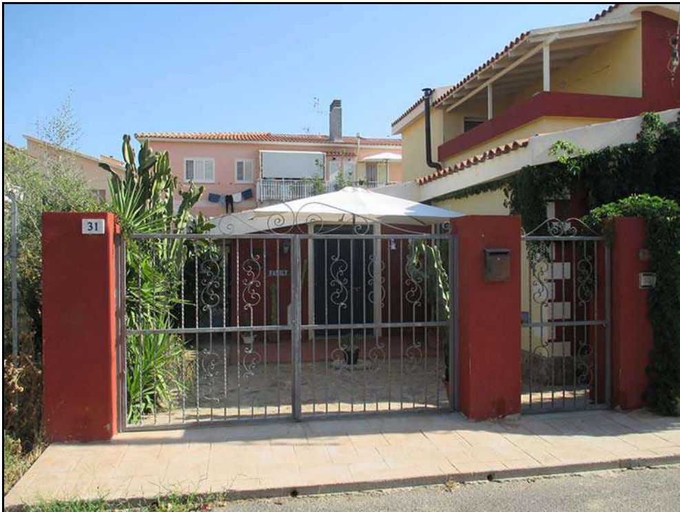
Vista dell'ingresso al sub 1.
