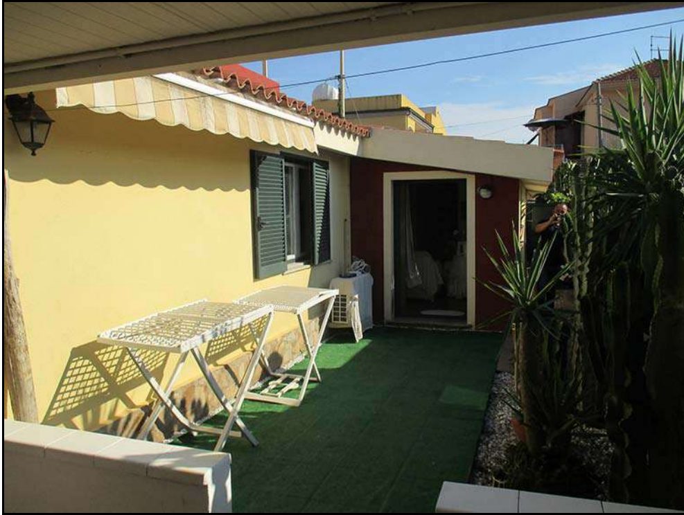
Vista dell'ingresso sul prospetto nord del sub 1.
