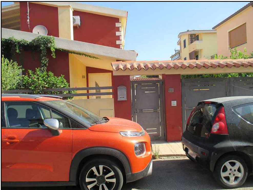
Vista dell'ingresso al sub 2.
