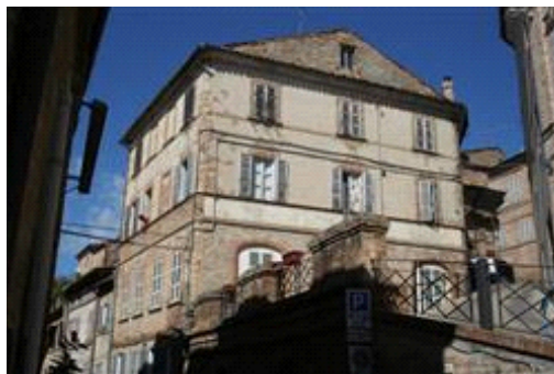
Angolo sud-est via Tornabuoni - via San Prospero
