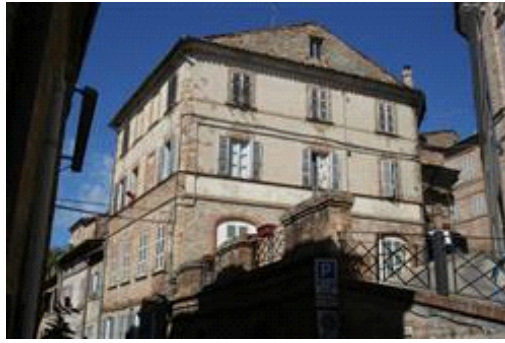
Angolo sud-est via Tornabuoni - via San Prospero
