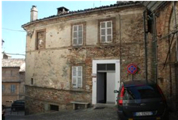
Prospetto nord-est su via San Prospero con ingresso condominiale
