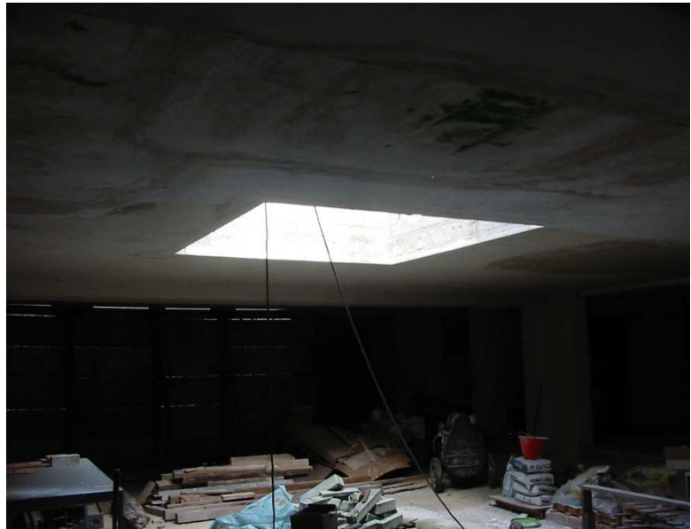
Particolari impianti area fredda
