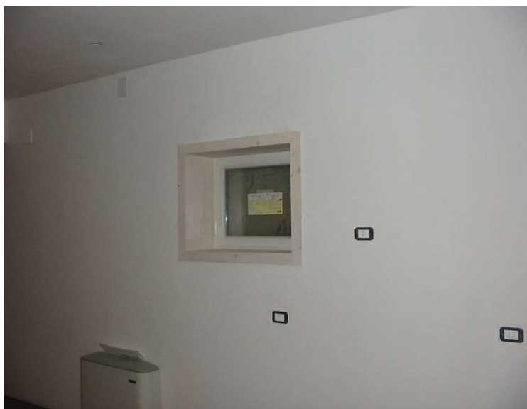
Interrato zona calda
