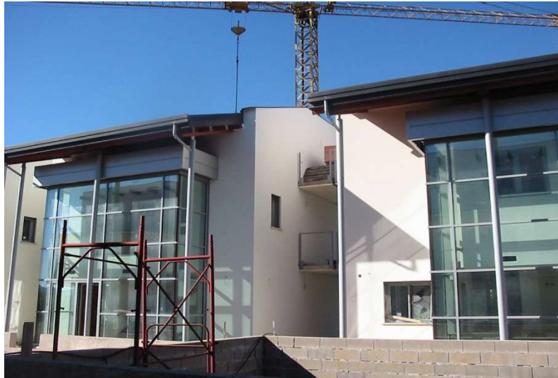
Particolare esterno unità 1-2 lato sud
