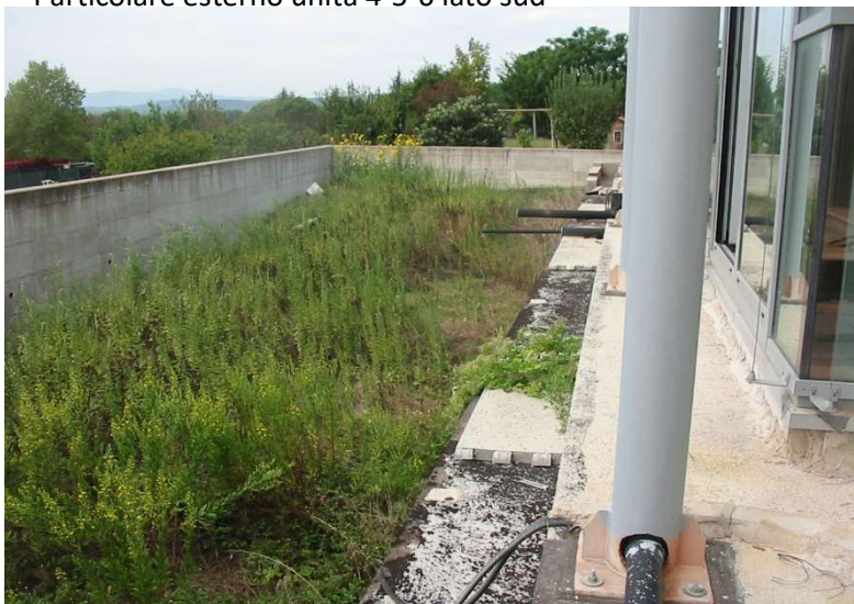
Particolare esterno unità 4-5-6 lato sud
