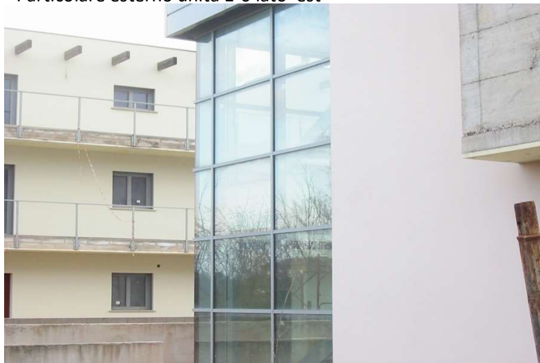
Particolare esterno unità 1-6 lato est
