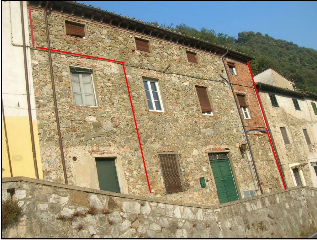
Figura 1 Prospetto lato OVEST Via del Brennero
