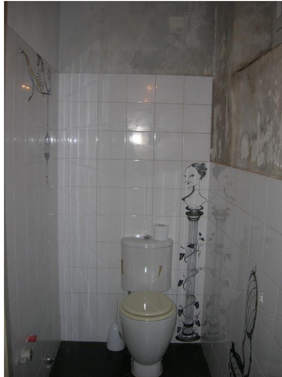
Figura 8 Bagno Piano Primo
