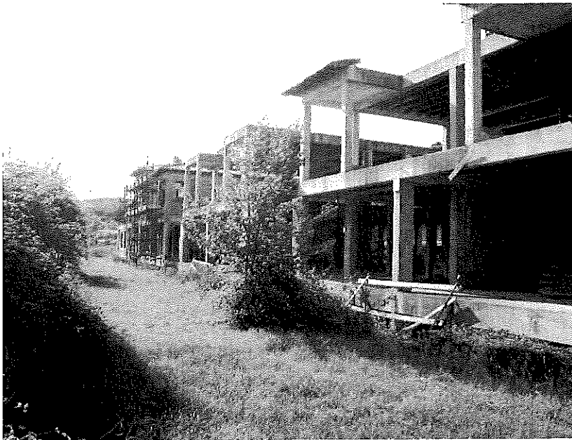
Figura 18 - Vista parziale del fabbricato "B" dalla corte esterna lato sud
