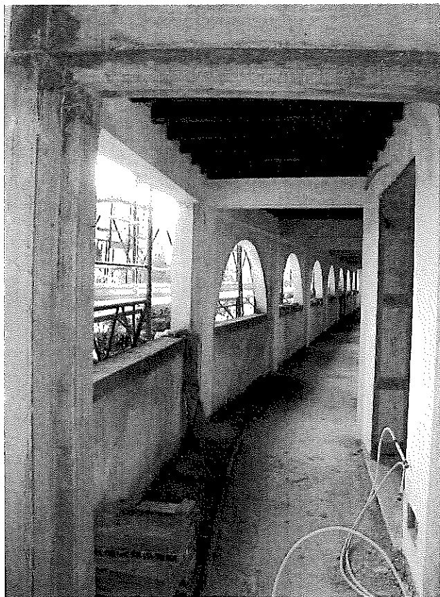
Figura 15 - Vista d'insieme del fabbricato "A" - logge piano terra
