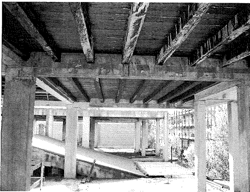
Figura 20 - vista parziale piano primo e carport fabbricato "B".
