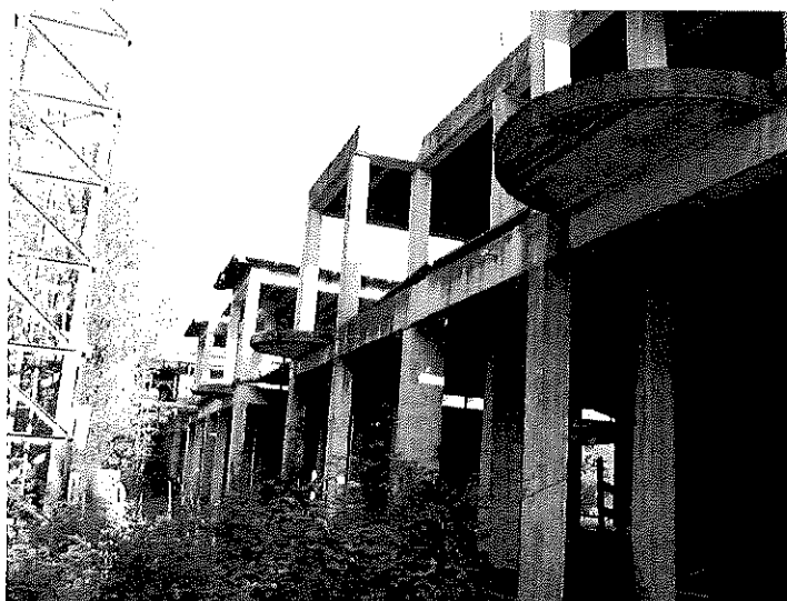
Figura 10 - Vista porzione fabbricato "B" dalla corte esterna lato fabbricato "A"
