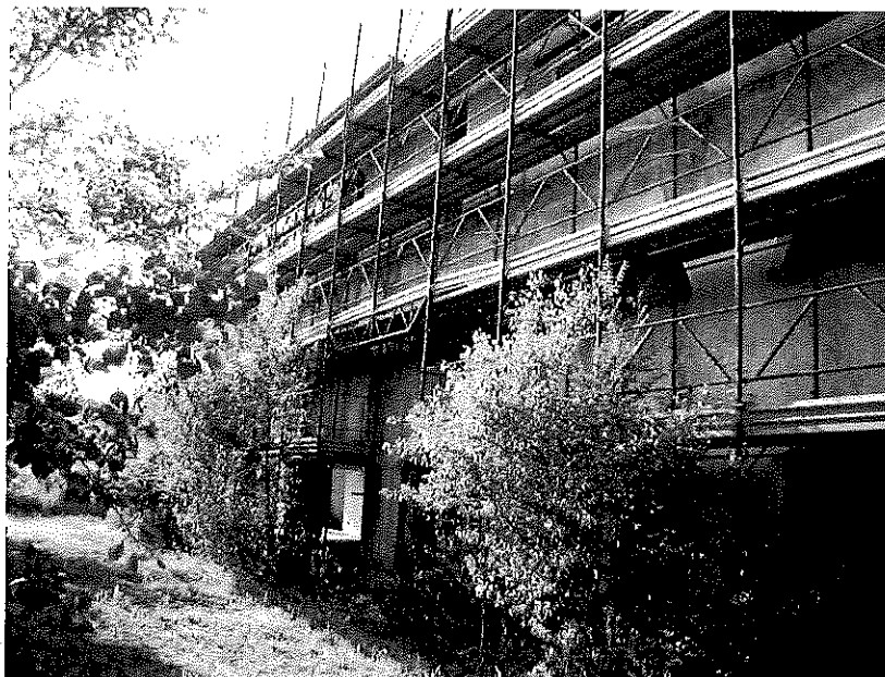
Figura 7 - Vista porzione fabbricato "A" dalla corte esterna lato fabbricato "B"
