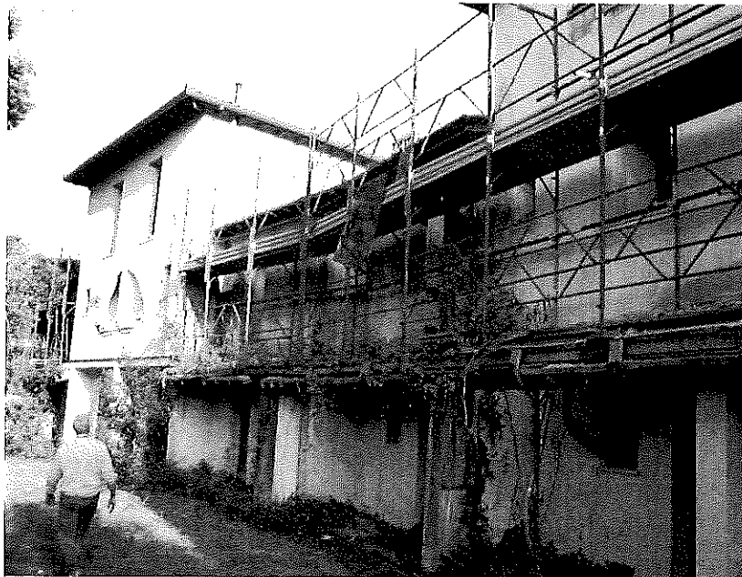
Figura 6 - Vista porzione fabbricato "A" dalla corte esterna confine nord del lotto
