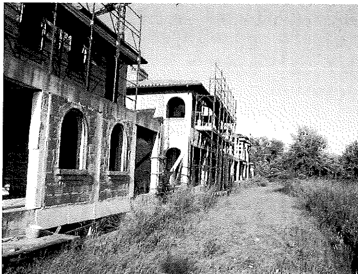
Figura 9 - Vista porzione fabbricato "B" dalla corte esterna confine sud del lotto
