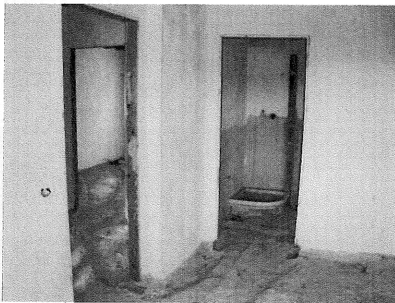
Figura 13 - Particolare appartamento al piano primo fabbricato "A"
