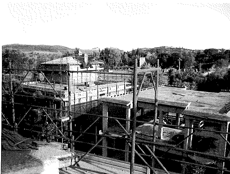
Figura 17 - Vista parziale del fabbricato "B" dalla corte esterna lato nord
