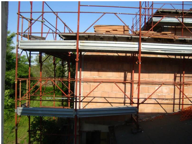
FIG. 11 VISTA ESTERNA PORZIONE LATERALE APP. N. 9
