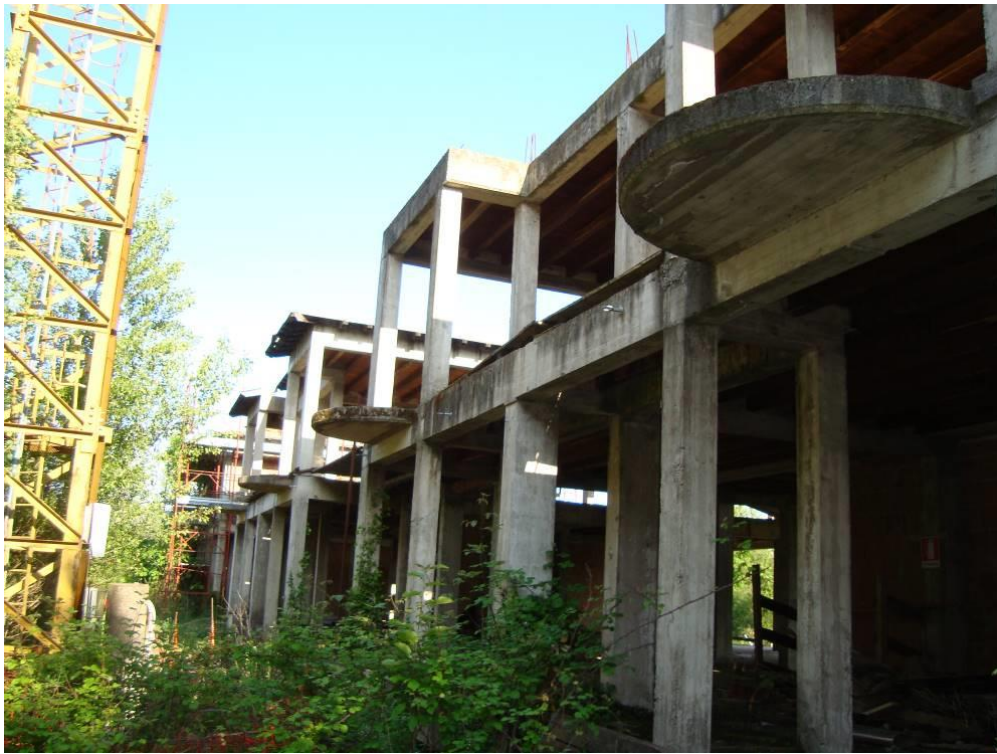
FIG. 27- VISTA PROSPETTO FABBRICATO LATO PROSPICIENTE FABBRICATO "A"
