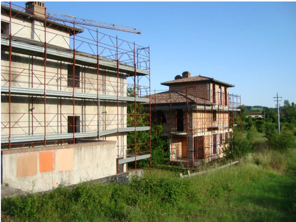
FIG. 32- VISTA ESTERNA FABBRICATO LATO OVEST
