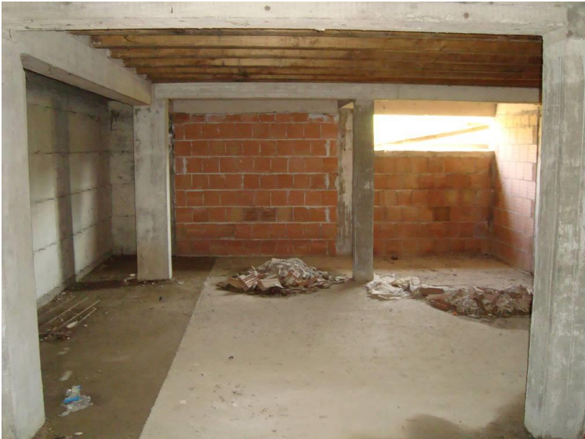
FIG. 22 VISTA DEP.OCCASIONALE APP.N. 1 PIANO INTERRATO LATO SUD
