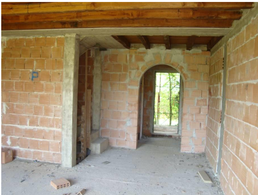
FIG. 16- VISTA APP. N.4 PIANO TERRA
