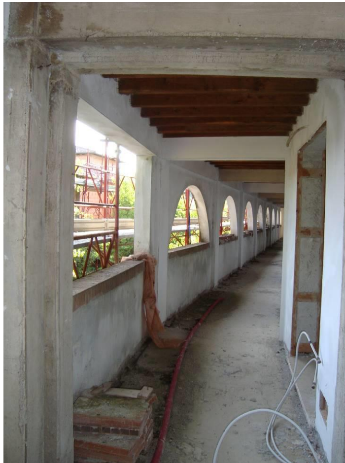
FIG. 9 - VISTA LOGGE APPARTAMENTI PIANO TERRA
