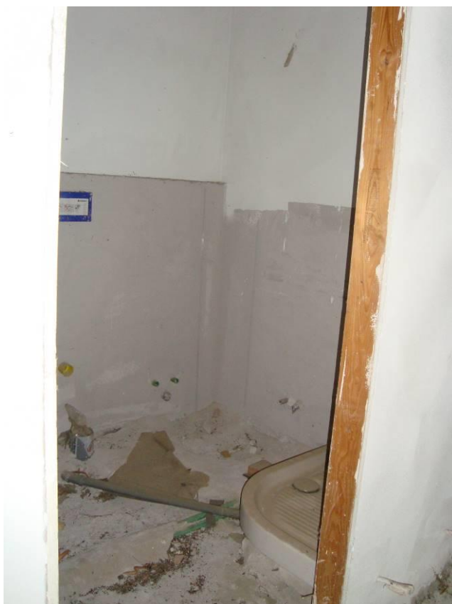
FIG. 20- VISTA BAGNO APP. N. 7 PIANO PRIMO
