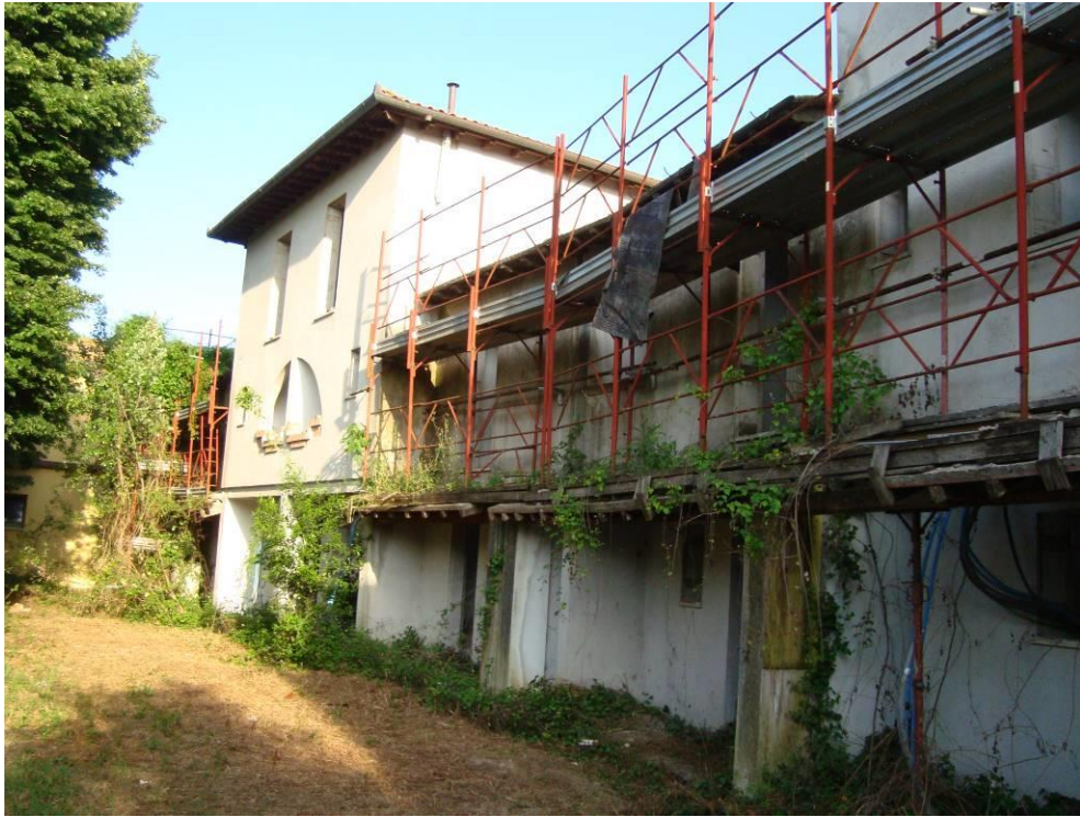
FIG. 31- VISTA ESTERNA FABBRICATO LATO NORD
