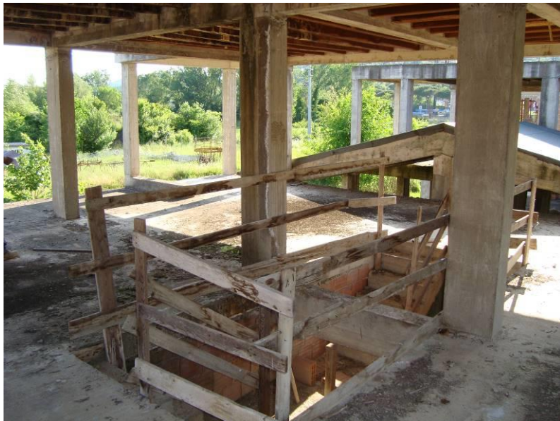
FIG. 12 VISTA STRUTTURE PIANO PRIMO APP.N.7 E N.8
