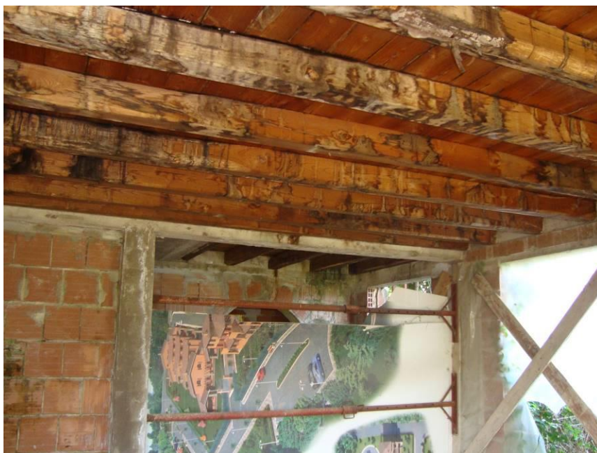
FIG. 5 VISTA LOGGIA PIANO TERRA APP. N. 10
