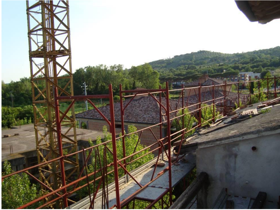
FIG. 29- VISTA DALL'ALTO PORZIONE FABBRICATO LATO PROSPICIENTE FABBRICATO "A"
