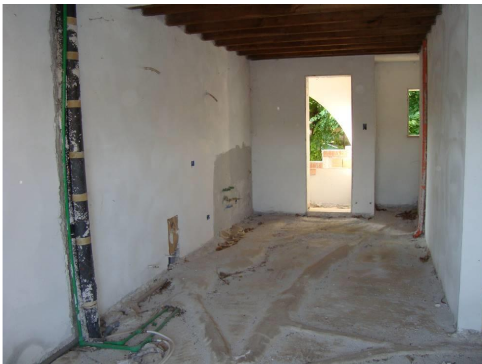
FIG. 26- VISTA SOGGIORNO APP.N. 13 PIANO PRIMO
