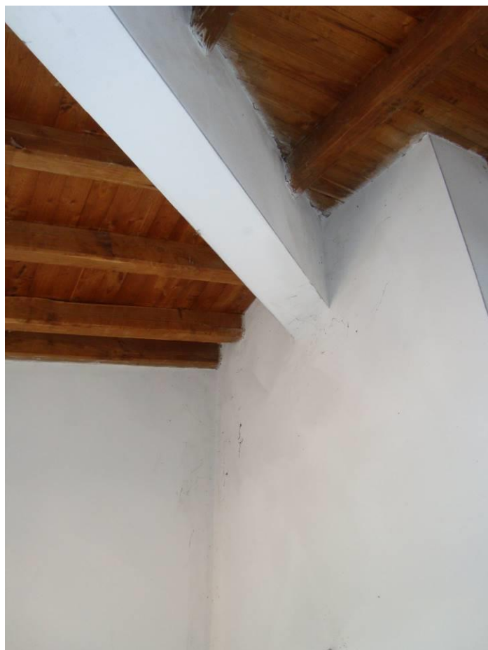
FIG. 29- VISTA DEP.OCCASIONALE APP.N. 13 PIANO SECONDO
