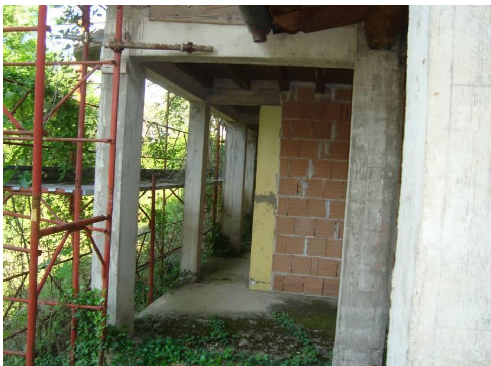
FIG. 8- VISTA CARPORT ADIACENTE APP. N.9
