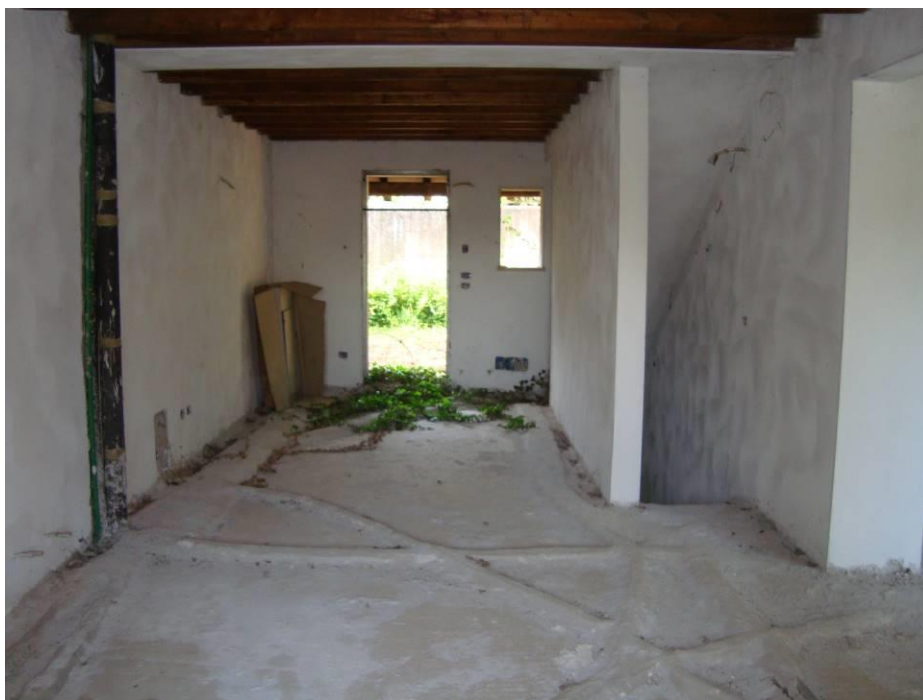
FIG. 21- VISTA SOGGIORNO APP. N. 6 PIANO TERRA
