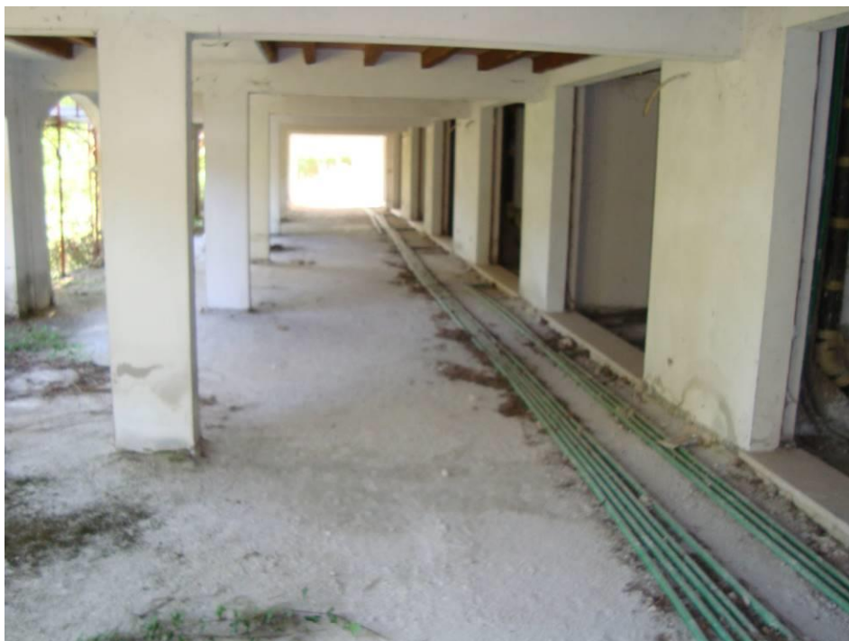
FIG. 2- VISTA PORTICATO PIANO INTERRATO
