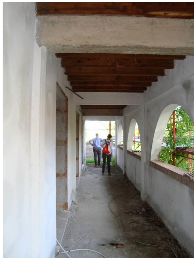
FIG. 8- VISTA LOGGE APPARTAMENTI PIANO TERRA
