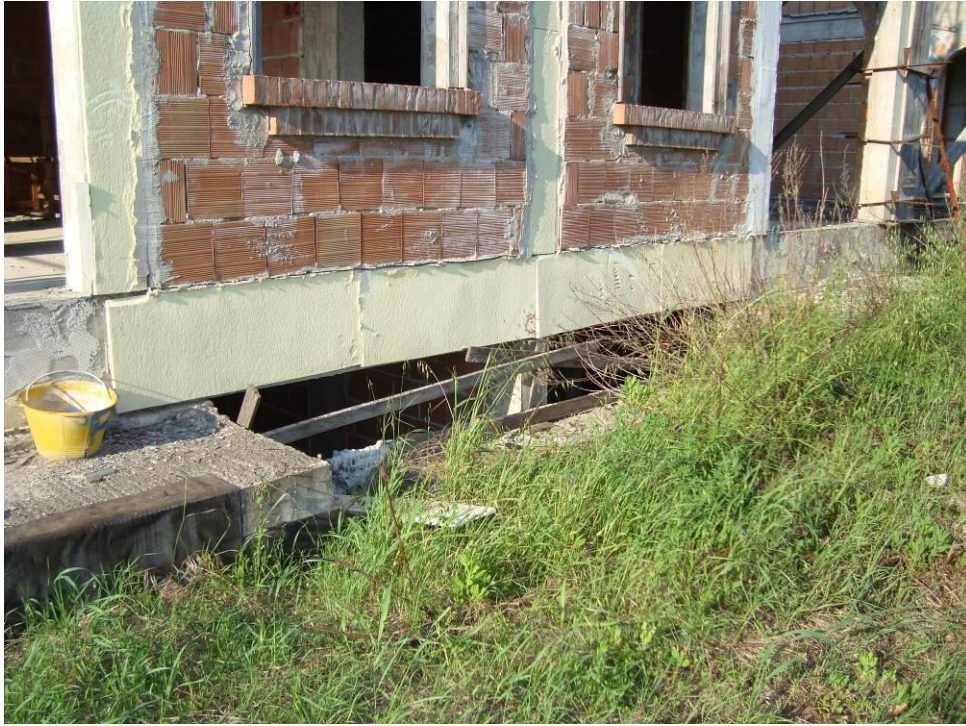
FIG. 25 VISTA PORZIONE SCANNAFOSSO LATO SUD
