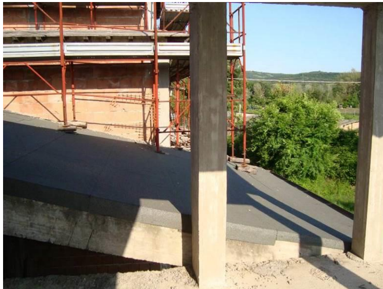
FIG. 10 VISTA PORZIONE COPERTURA CARPORT ADIACENTE APP.N.8
