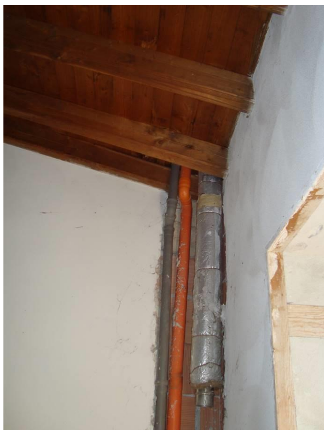
FIG. 28- VISTA DEP.OCCASIONALE APP.N. 13 PIANO SECONDO
