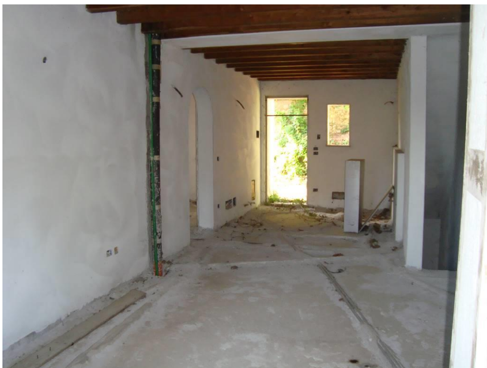
FIG. 16- VISTA APP.N. 8 PIANO TERRA
