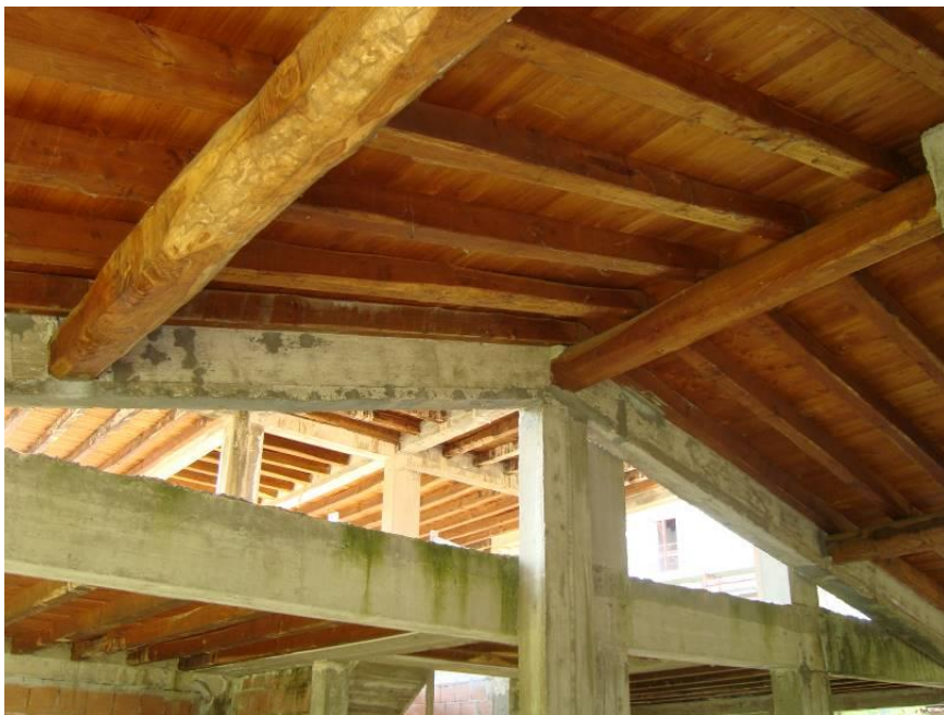
FIG. 7- VISTA CARPORT ADIACENTE APP. N.9
