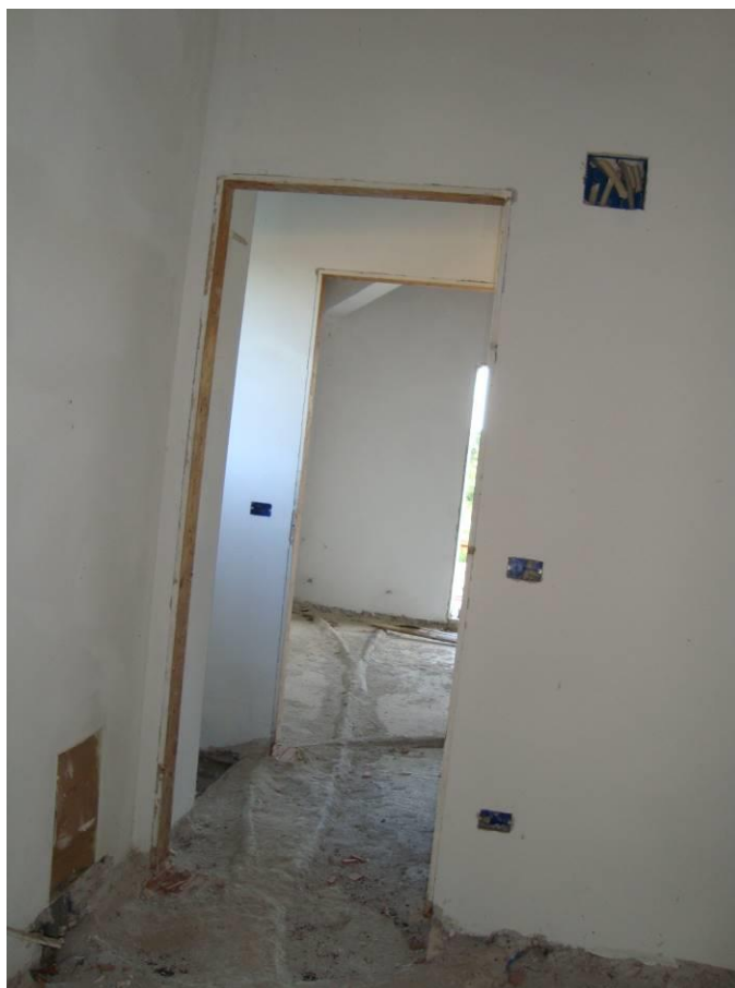
FIG. 27- VISTA DEP.OCCASIONALE APP.N. 13 PIANO SECONDO
