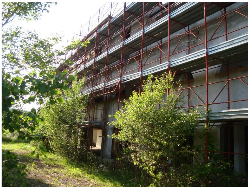
FIG. 1- VISTA LATO CORTE
