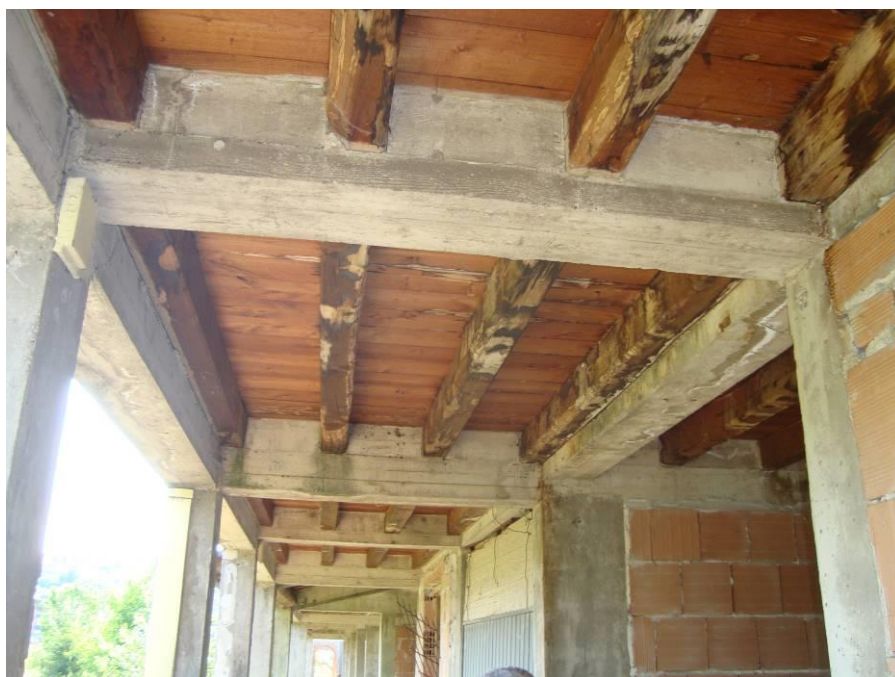
FIG. 4 VISTA LOGGIA PIANO TERRA
