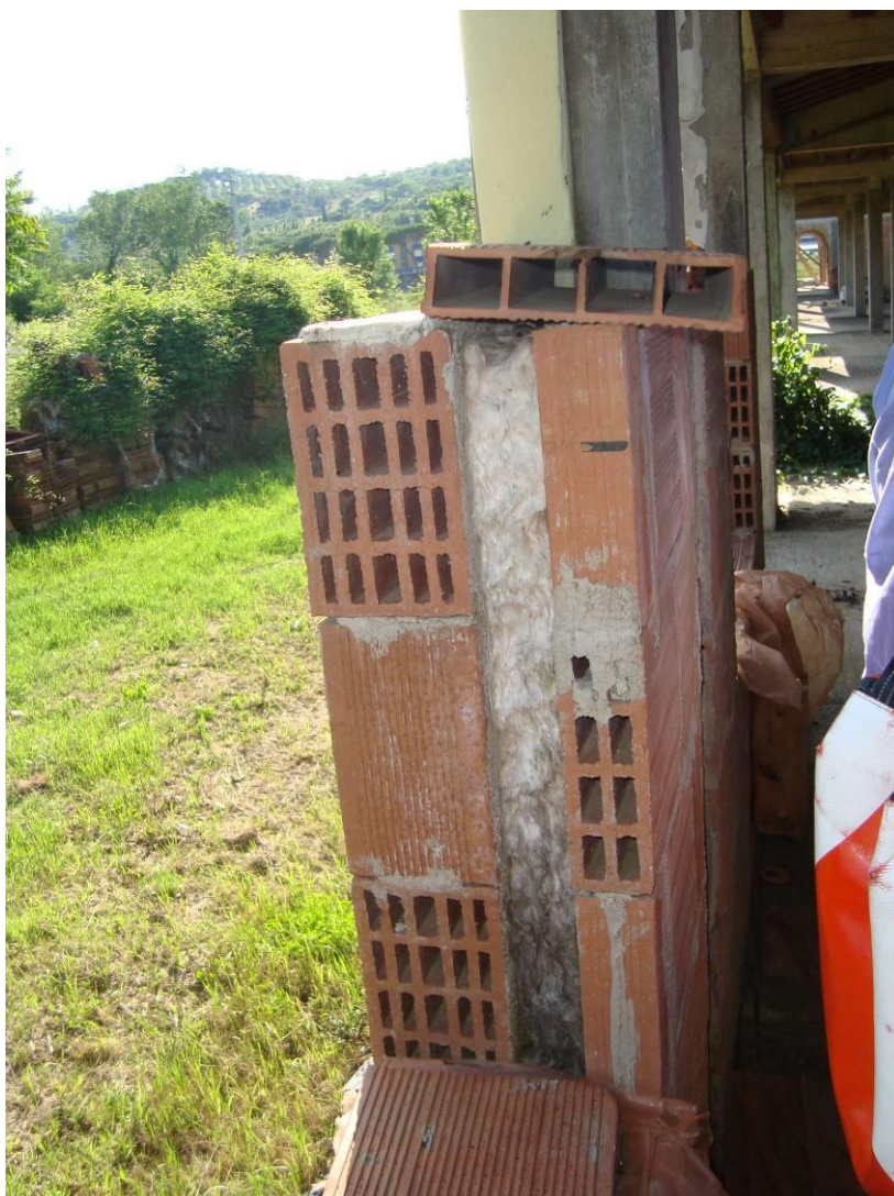
FIG. 6 -VISTA PORZIONE TAMPONATURA LOGGIA PIANO TERRA APP. N. 9
