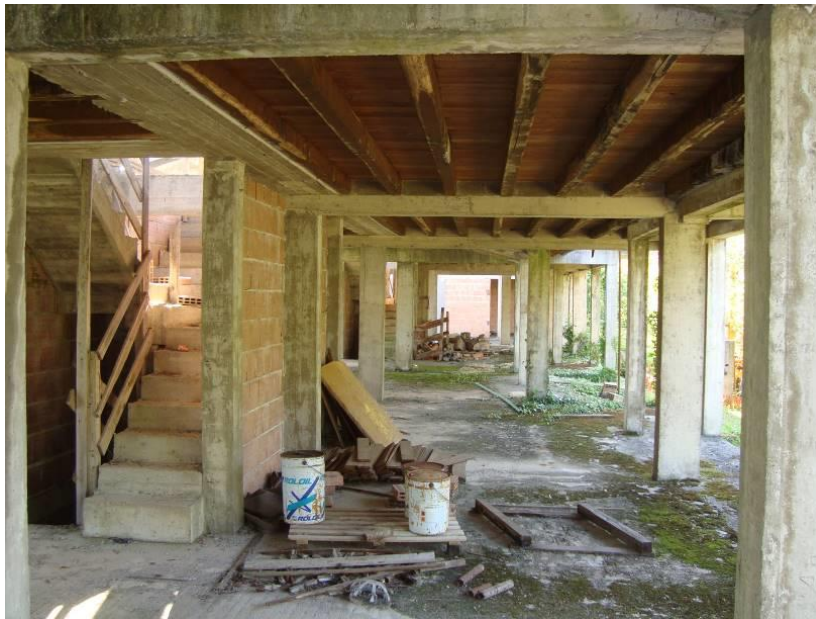
FIG. 9 VISTA CARPORT ADIACENTE APP. N.8 PIANO TERRA
