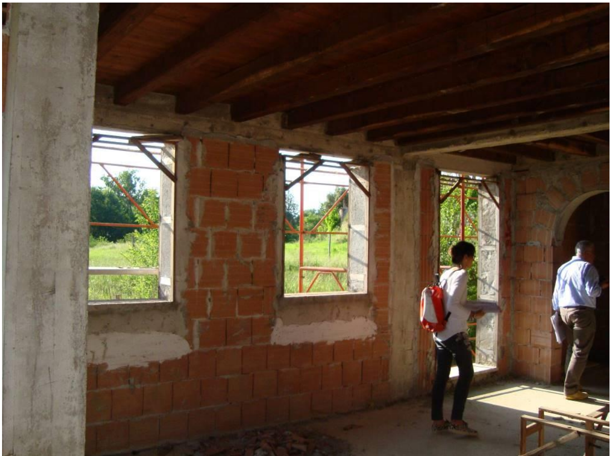
FIG. 20- VISTA SOGGIORNO APP. N.1 PIANO TERRA
