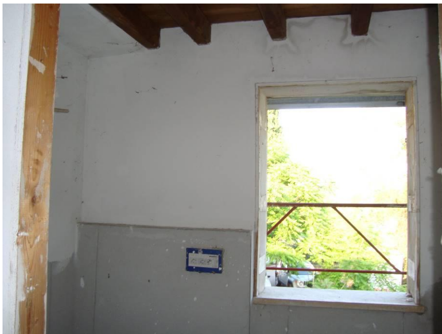
FIG. 14- VISTA BAGNO APP. N.9 PIANO PRIMO
