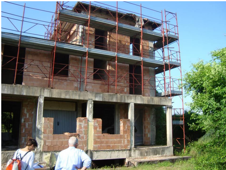
FIG. 2- VISTA ESTERNA PORZIONE FABBRICATO LATO SUD
