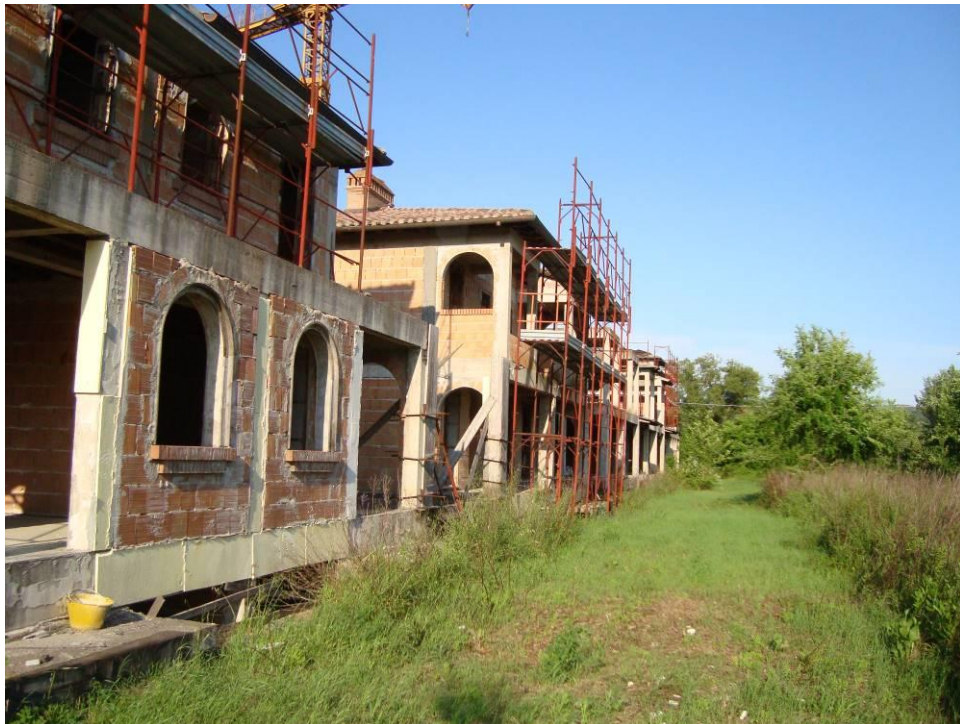
FIG. 26- VISTA PROSPETTO FABBRICATO LATO SUD
