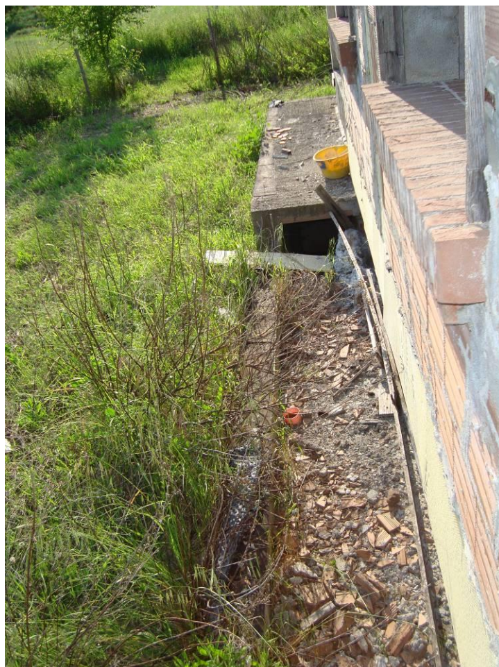
FIG. 24- VISTA PORZIONE SCANNAFOSSO COPERTO LATO OVEST
