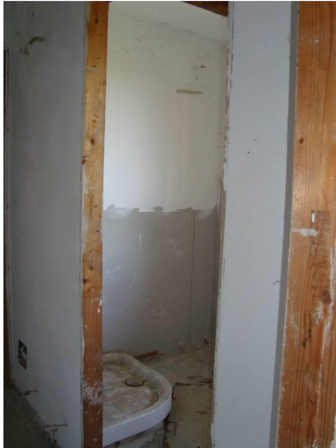
FIG. 13- VISTA BAGNO APP. N. 9 PIANO PRIMO
