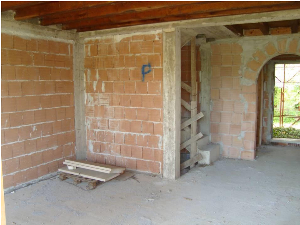
FIG. 19- VISTA SOGGIORNO APP. N.2 PIANO TERRA
