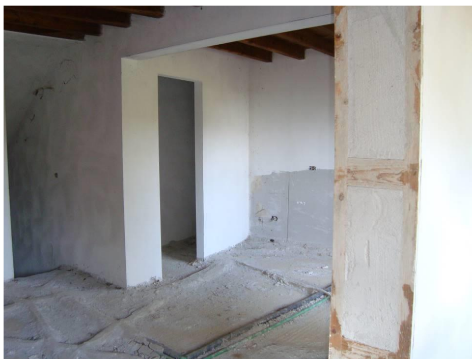
FIG. 22- VISTA APP. N. 6 PIANO TERRA
