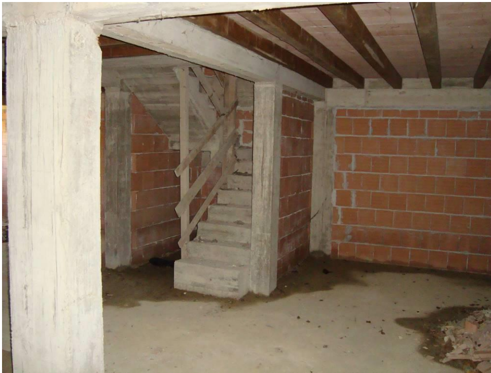
FIG. 23- VISTA SCALA INTERNA DEP.OCCASIONALE APP.N. 1 PIANO INTERRATO
