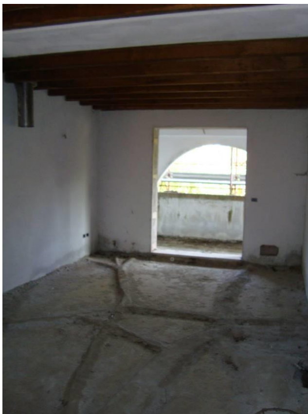
FIG. 18- VISTA SOGGIORNO APP.N.8 PIANO TERRA
