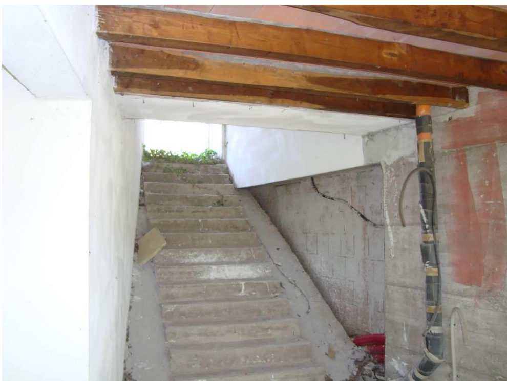
FIG. 3- VISTA SCALA CENTRALE ACCESSO PIANO TERRA
