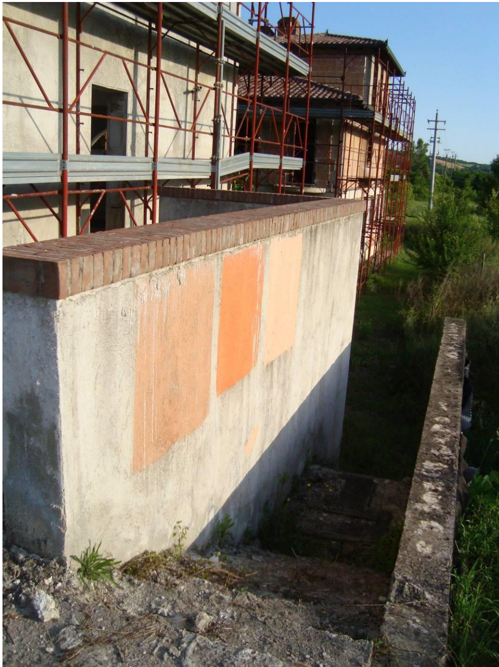
FIG. 33 VISTA SCALA SCOPERTA LATO OVEST
