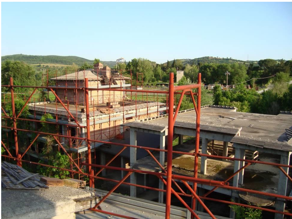
FIG. 28- VISTA DALL'ALTO PORZIONE FABBRICATO LATO PROSPICIENTE FABBRICATO "A"
