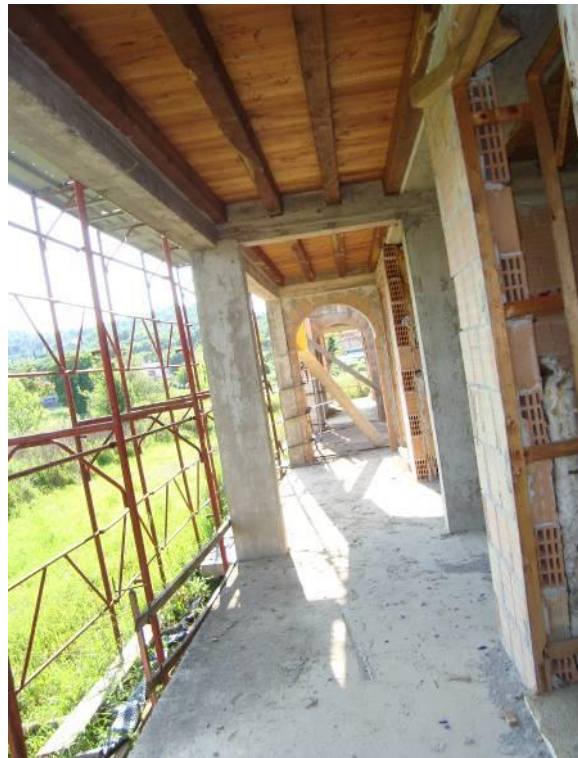
FIG. 15- VISTA LOGGIA PIANO TERRA APP. N.4
