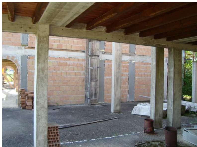
FIG. 14 VISTA CARPORT ADIACENTE APP. N.14 PIANO TERRA
