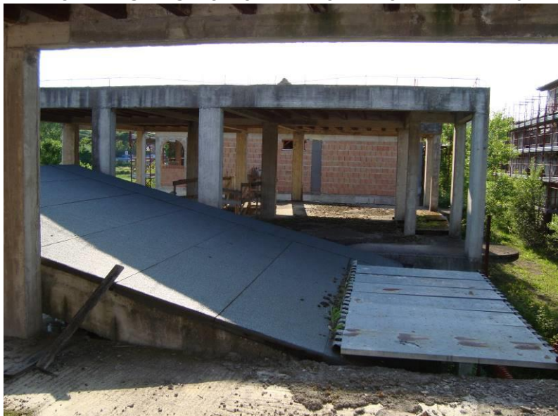
FIG. 13 VISTA PORZIONE COPERTURA CARPORT ADIACENTE APP.N.7
