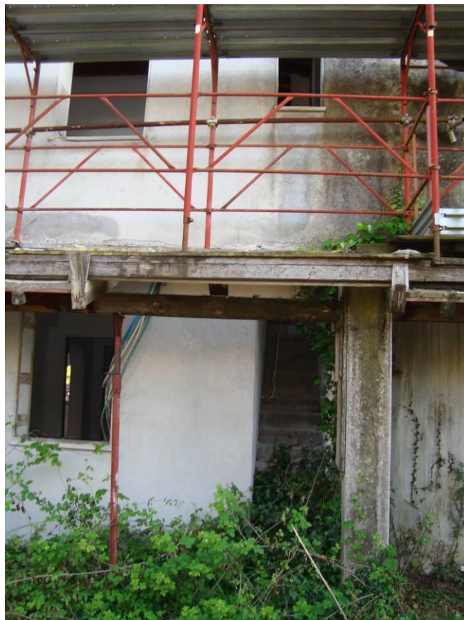
FIG. 24- VISTA ESTERNA FABBRICATO LATO NORD
