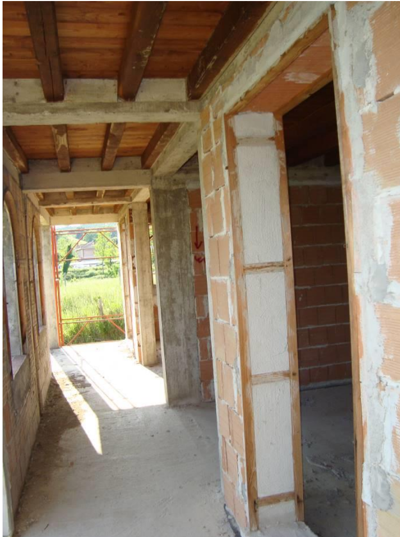
FIG. 18- VISTA LOGGIA PIANO TERRA APP.N. 1 E N.2
