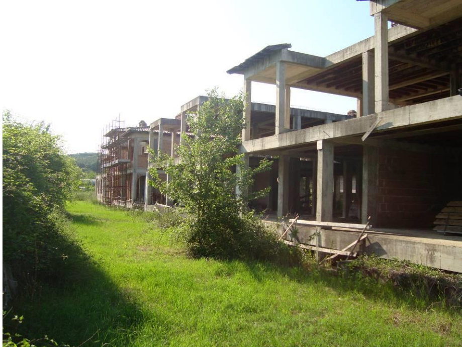
FIG. 1 VISTA ESTERNA DEL FABBRICATO LATO SUD
