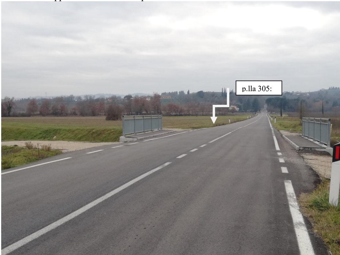
Lavori di allargamento della viabilità già eseguito
