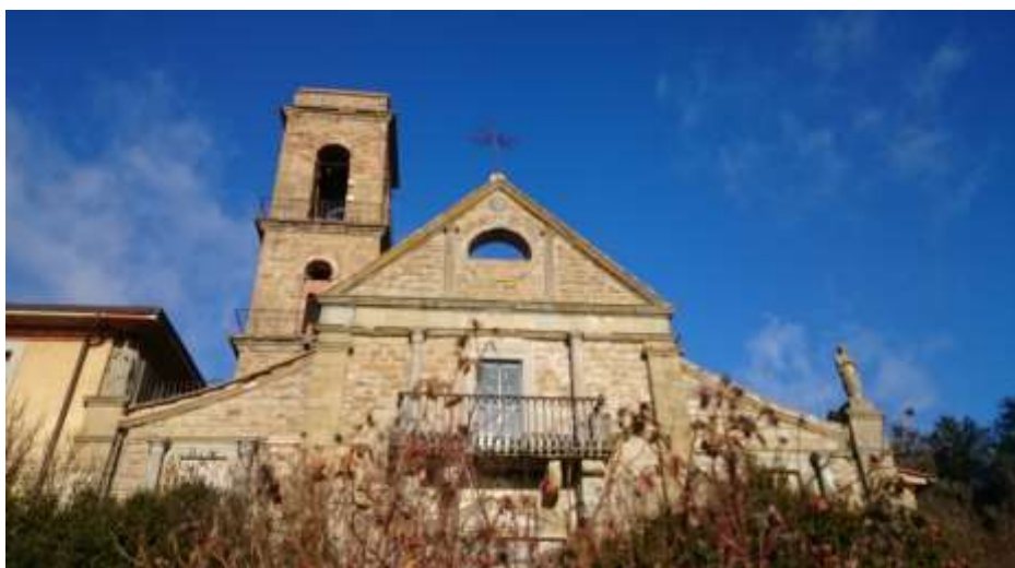
Facciata principale sub. 1
