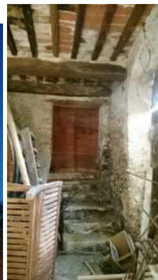
Ingresso cantina sub.2
