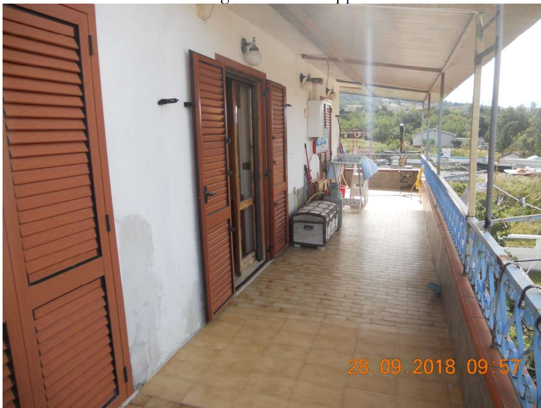
Terrazzo collegato con altro appartamento
