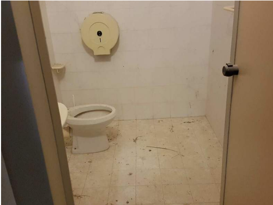
- Foto 7 - Corpo Uffici - Piano Primo
