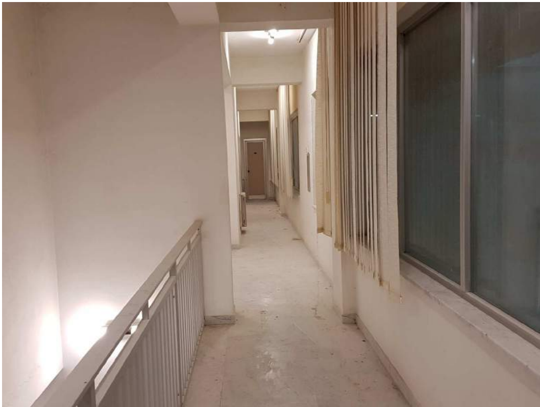
- Foto 8 - Corpo Uffici - Piano Primo
