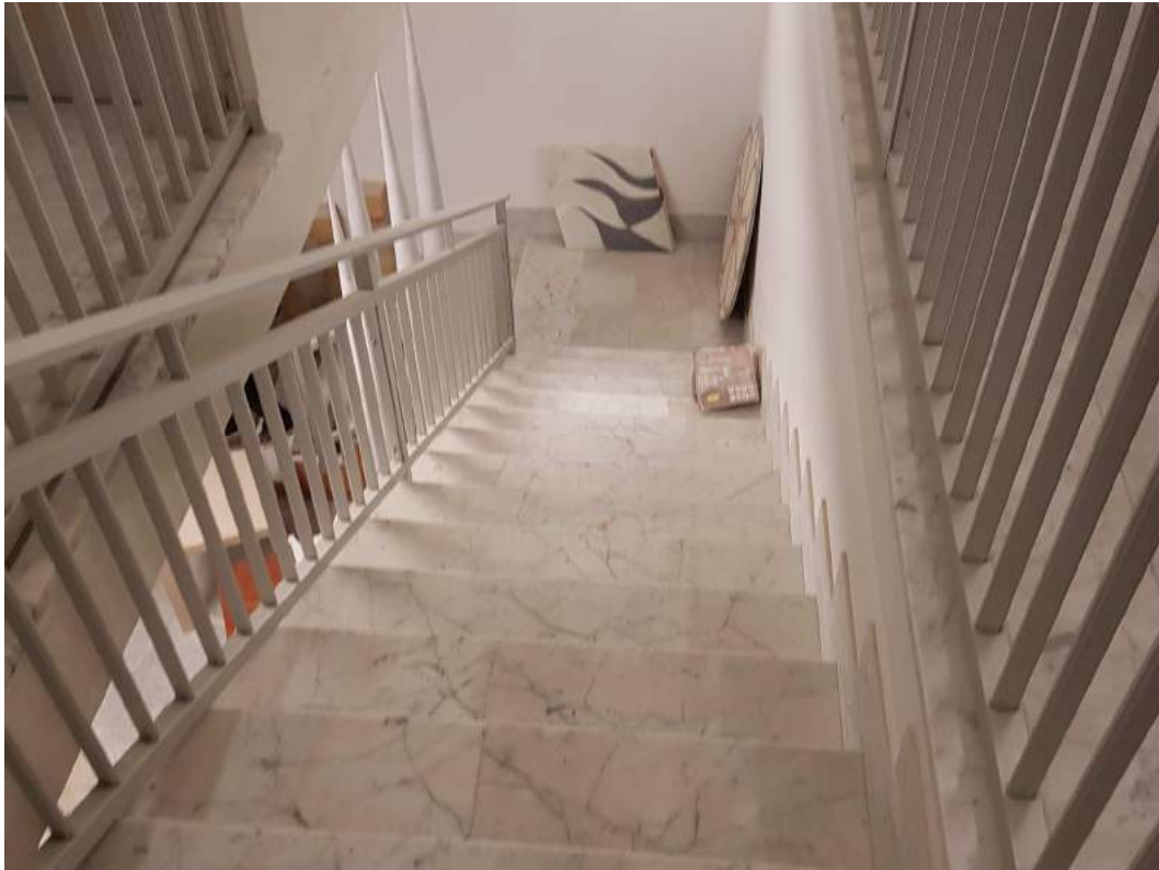
- Foto 9 - Scala di collegamento dei due livelli del Corpo Uffici
