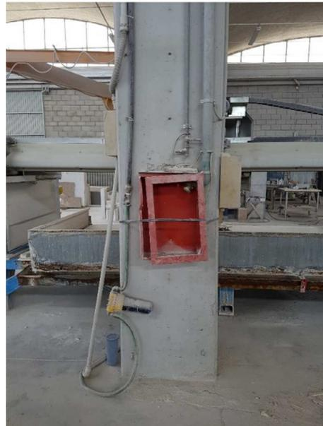
**Figura 7 - Idrante a muro**
