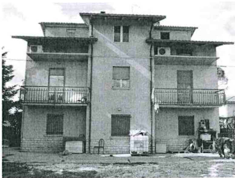
Foto 2 – vista del retro dell'edificio, dalla corte
