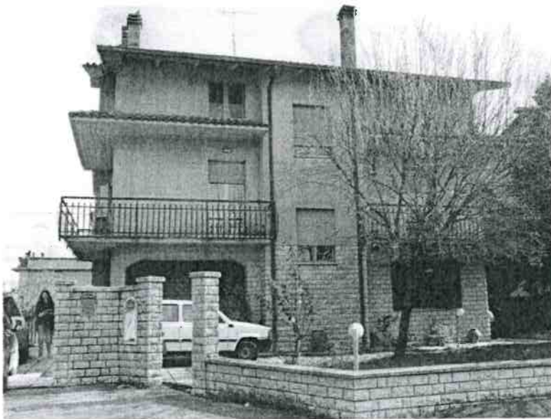
Foto 1 – vista dell'edificio dalla strada
