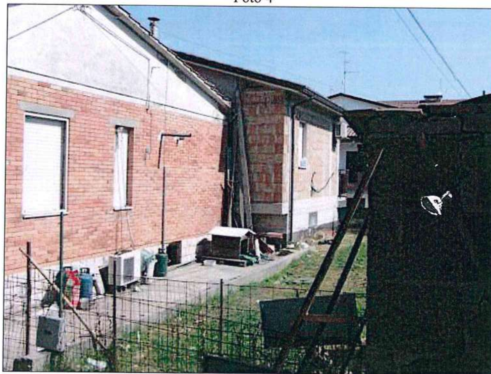
A sinistra: Bene B, nucleo originario, lato verso Est. Al centro: Bene B, ampliamento, lato verso Est. A destra: piccolo fabbricato fatiscente non censibile (ex p.lla 202 soppressa). Da Sud verso Nord.
