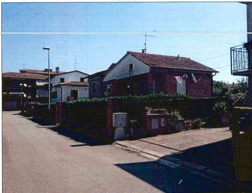
Da Via Picelli verso beni B e D, da Sud-Ovest verso Nord-Est
