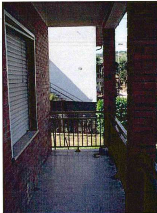
Bene B, portico, da Nord verso Sud
