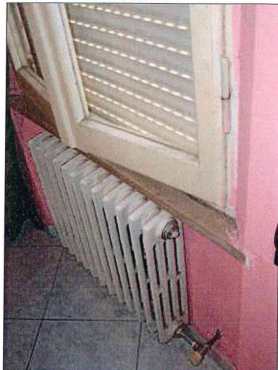
Bene B, soggiorno, infissi finestre e termosifoni
