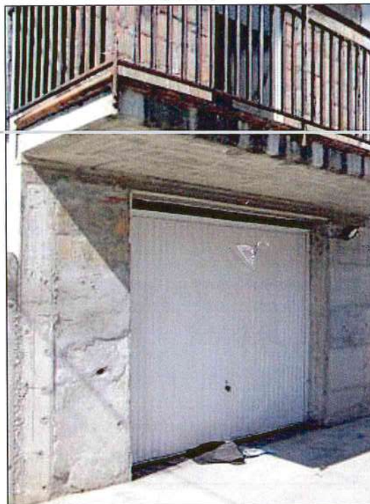
Porta basculante per l' accesso carrabile dal bene D al bene A
