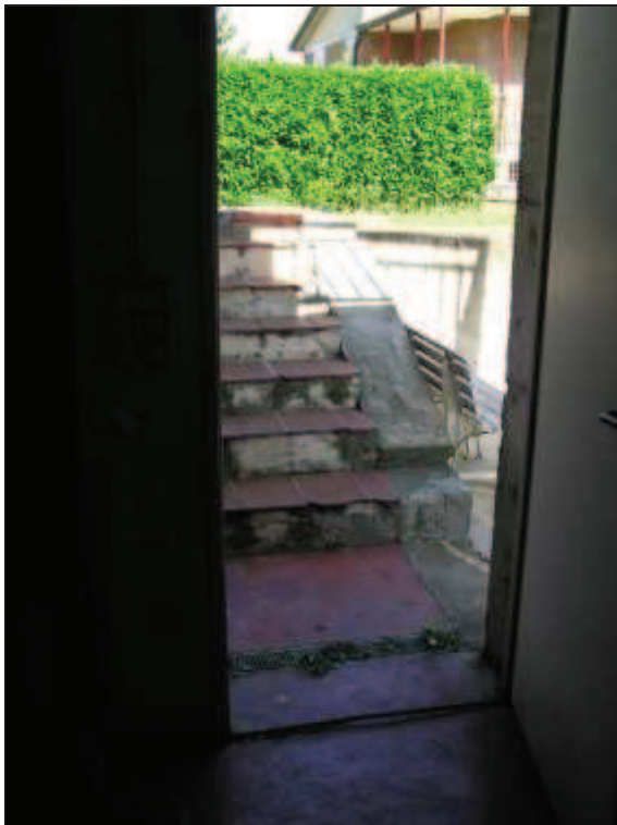
Rampa di scale collegante il bene A con il bene D, da S1 verso T, da Est verso Ovest.
