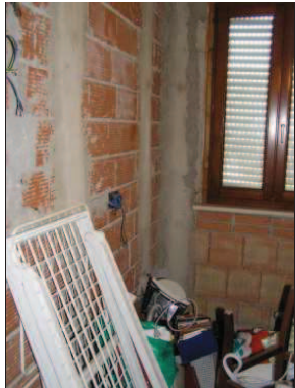
Bene B, vano rifinito al grezzo, da completare
