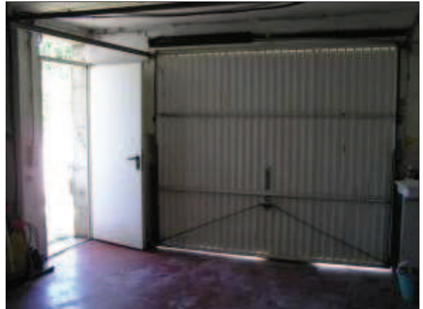
Bene A, interno, da Sud Est verso Nord Ovest, verso porta carrabile a destra, verso porta per accesso pedonale dal piano S1 al piano T a sinistra.
