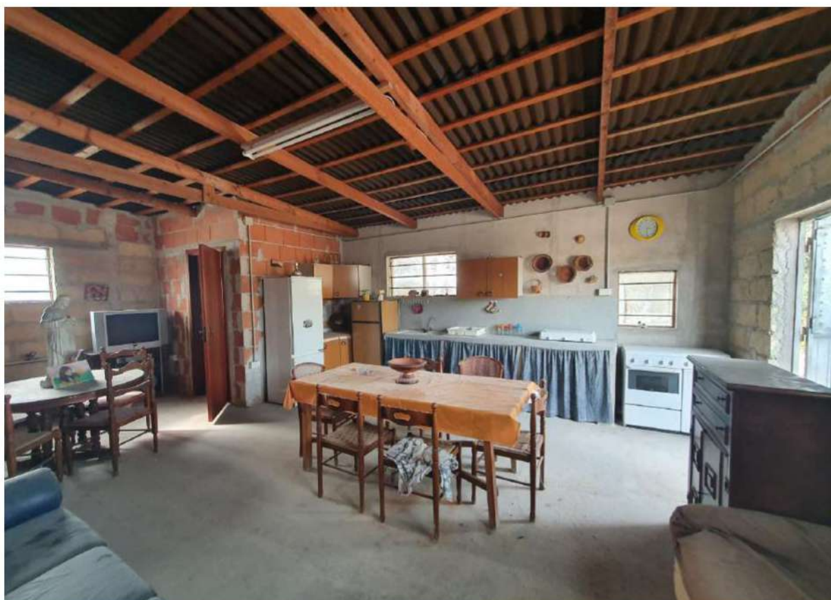
Foto 10 Lotto unico – Fabbricato abusivo e non censito particella 7 – vista interna
