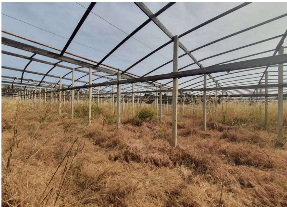
Foto 16 Lotto unico – Vista interna serra particella 7
