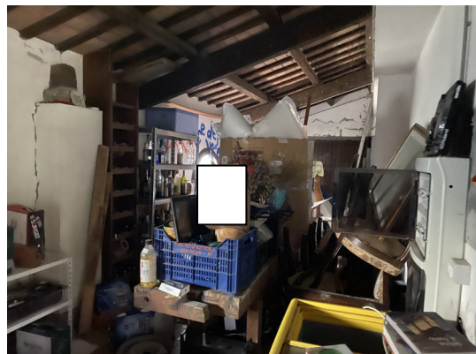
Foto 8: Autorimessa (ex varie-Sub. 2)_PT
