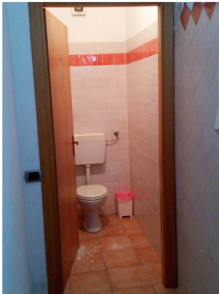
Foto 30: Vista wc adiacente sala ufficio - P.1°
