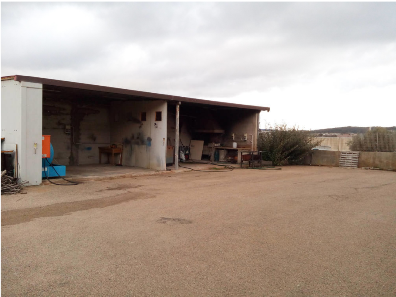
Foto 5: Particolare esterno – Tettoia
