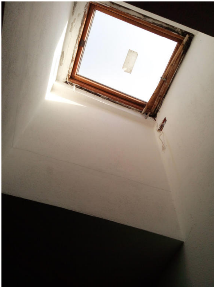
Foto 36: Vista pozzo luce in zona adibita a cucina - P.1°
