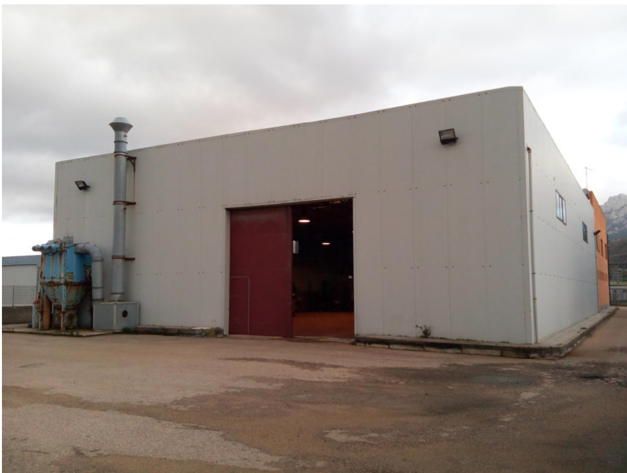
Foto 2: Vista Retro Esterna
