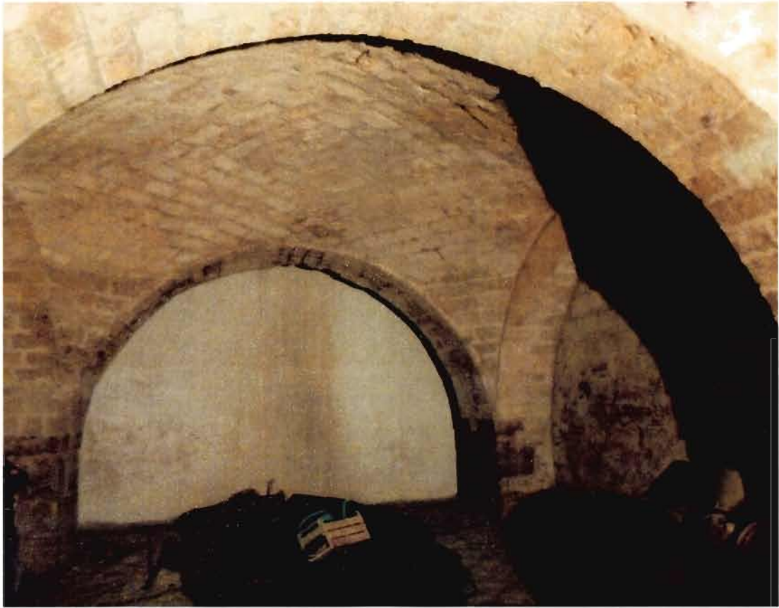
Foto 57. Barletta. Via Solferino, 22. Piano interrato.
