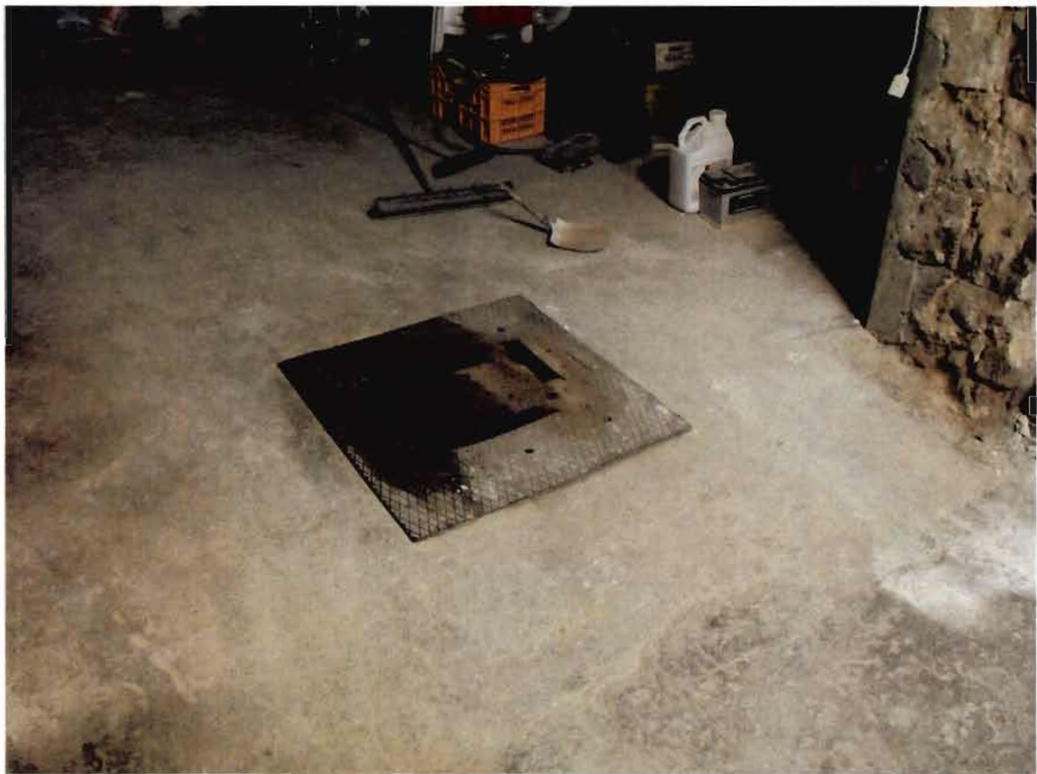
Foto 56. Barletta. Via Solferino, 22. Unità immobiliare in piano terra. Botola di accesso al piano interrato.
