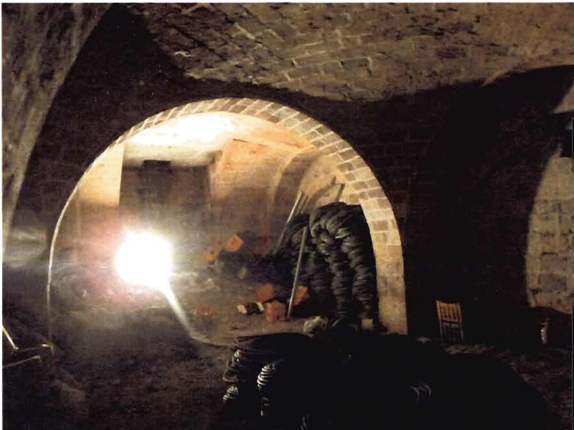
Foto 58. Barletta. Via Solferino, 22. Piano interrato.
