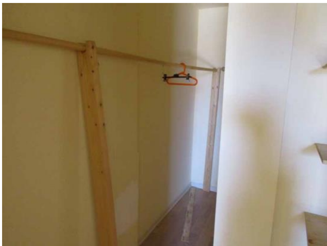
Foto 12 – LOTTO A - Pozzo luce annesso alla cabina armadio
