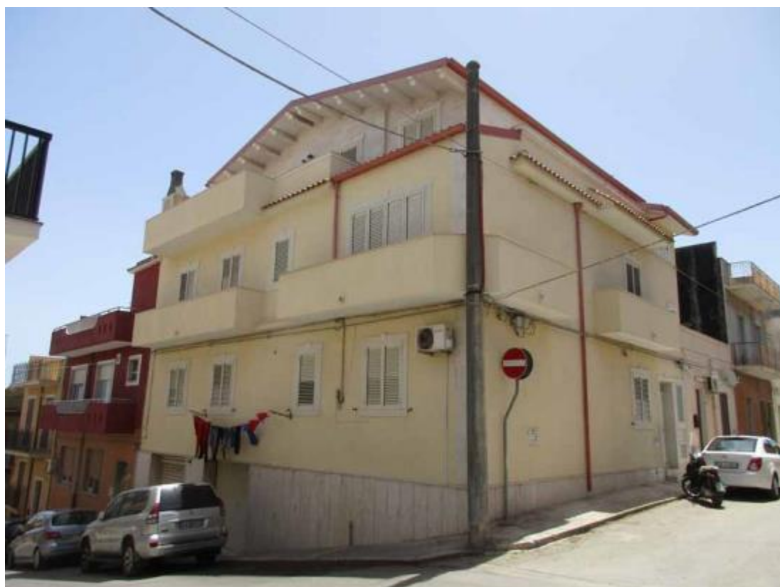
Foto 2 - Prospetto immobile via Ruggero Settimo, 57 - Pachino (SR) alla data del sopralluogo
