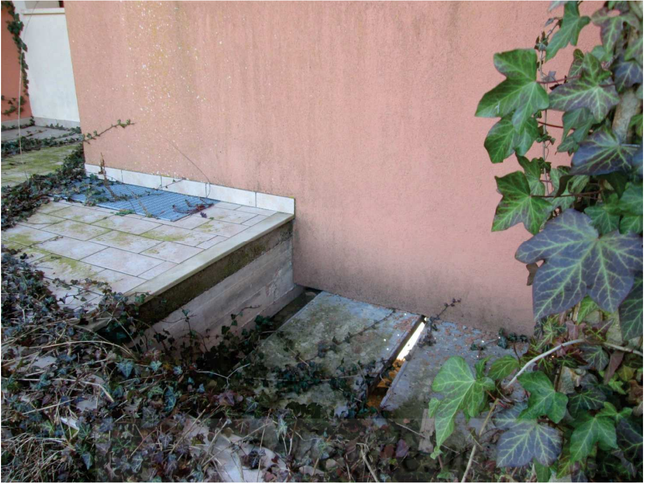
Predisposizione per installazione scala di collegamento tra il garage e il marciapiede del piano terra.
