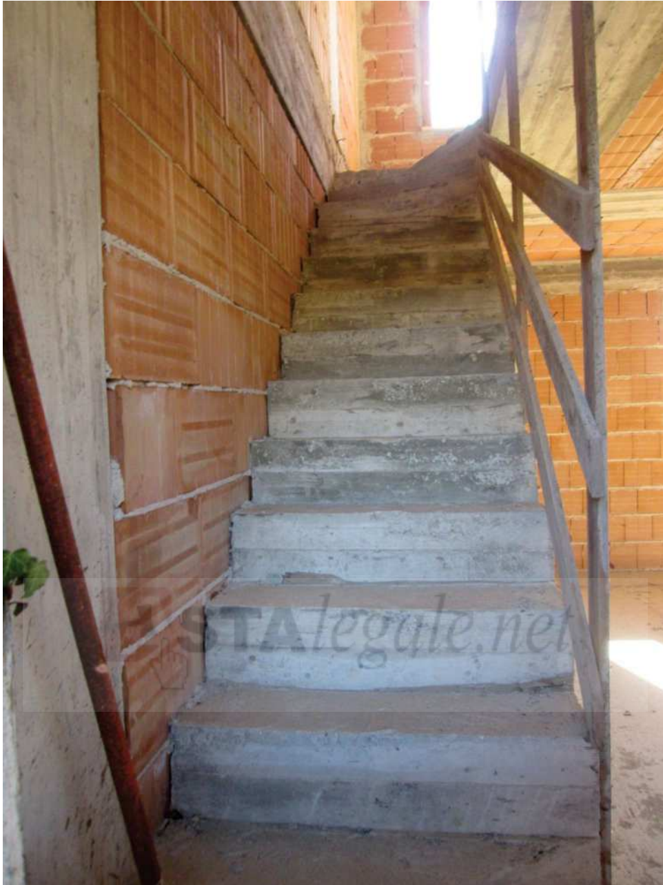
Scala interna di collegamento tra P.T. e P.1°
