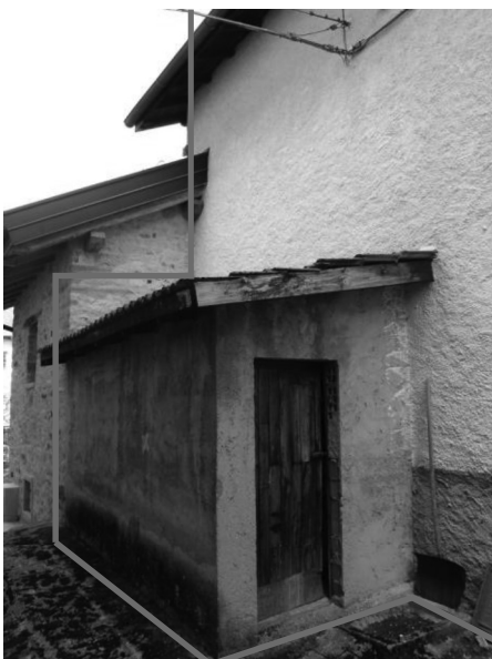
7 il locale deposito posto sul retro
