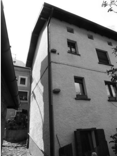
3 Angolo sinistro della facciata principale
