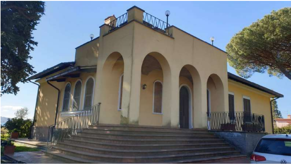
EDIFICIO A: foto esterne
