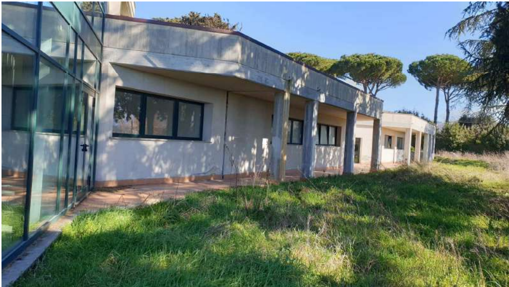
EDIFICIO B: viste esterne
