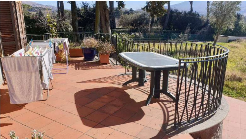
EDIFICIO A: foto terrazzi esterni
