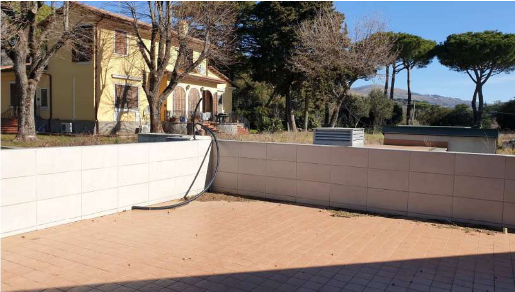
EDIFICIO B: foto esterne terrazzi e tetto giardino
