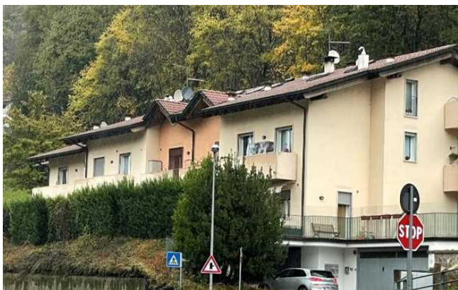
Vista del fabbricato da Sud Ovest
