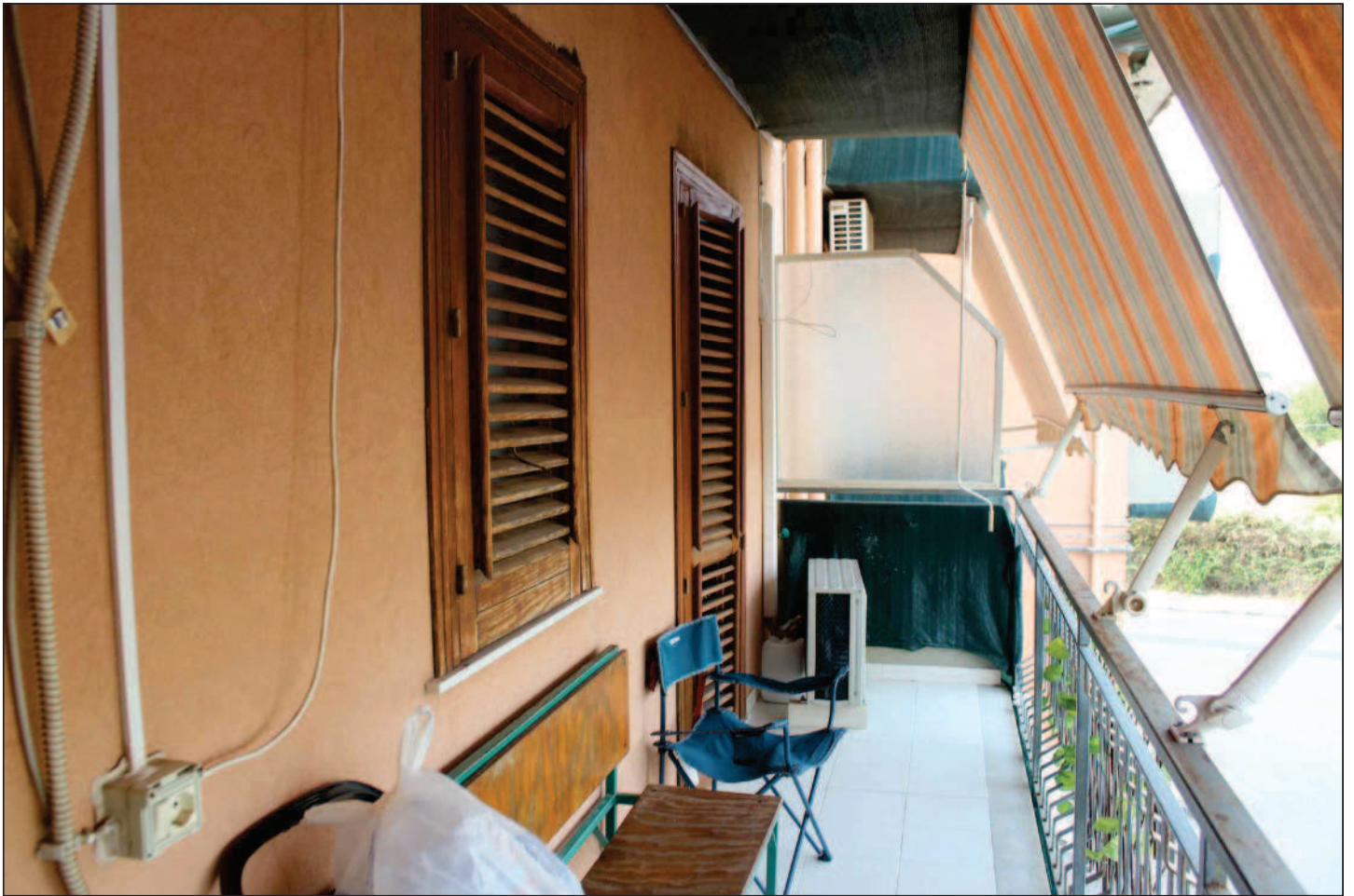
N.21 Vista Balcone "1" prospiciente su Via Kennedy
