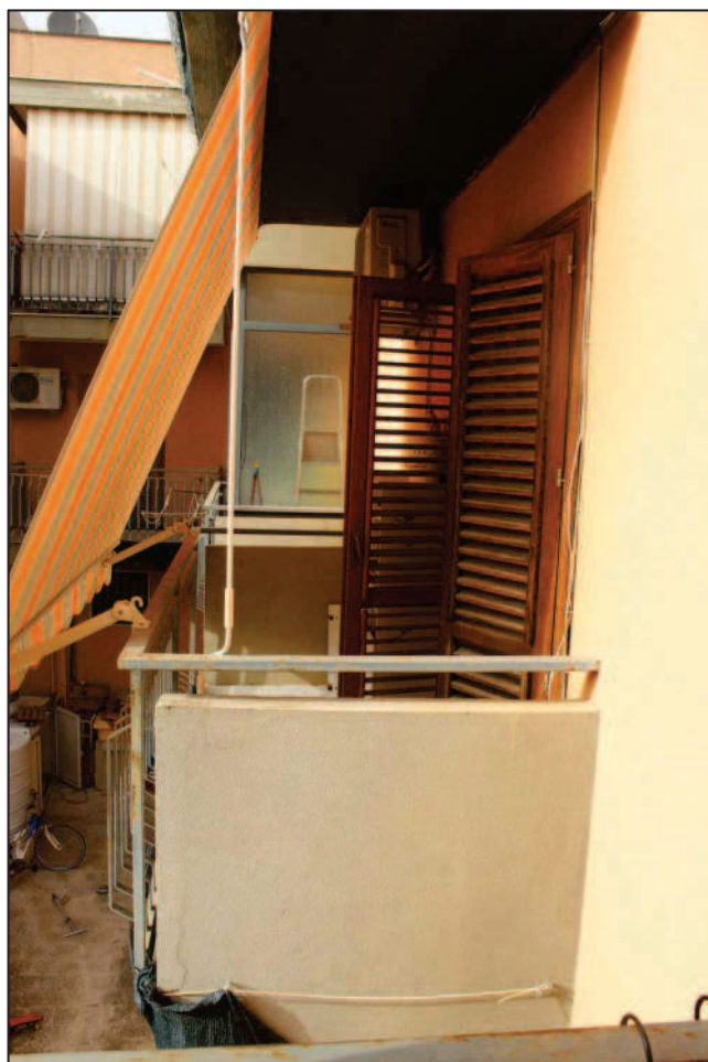
N.25 Vista Balcone "3"
