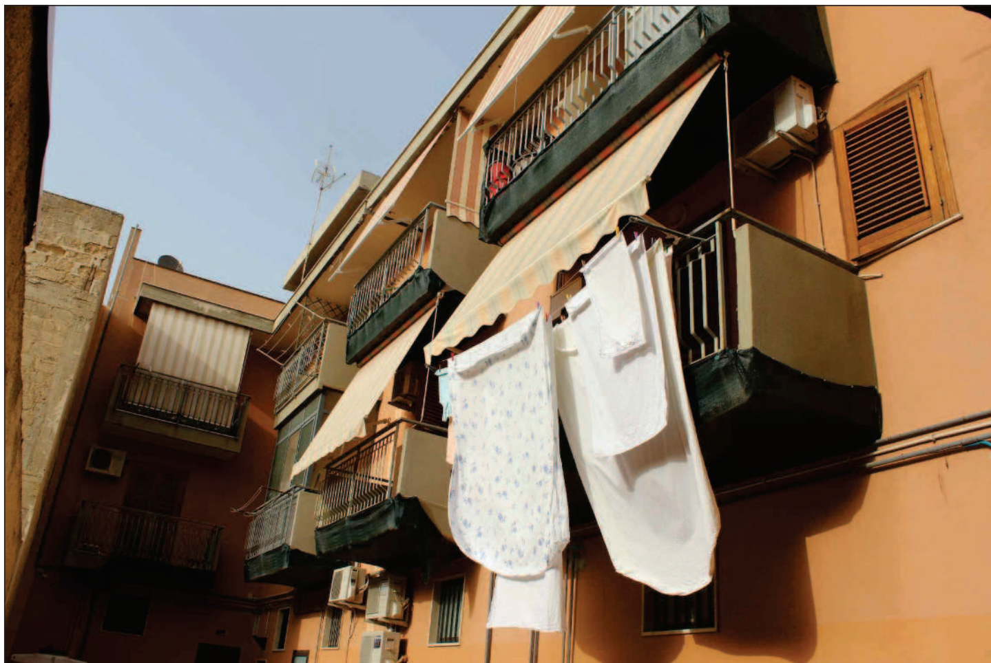
N.3 Vista da cortile condominiale interno
