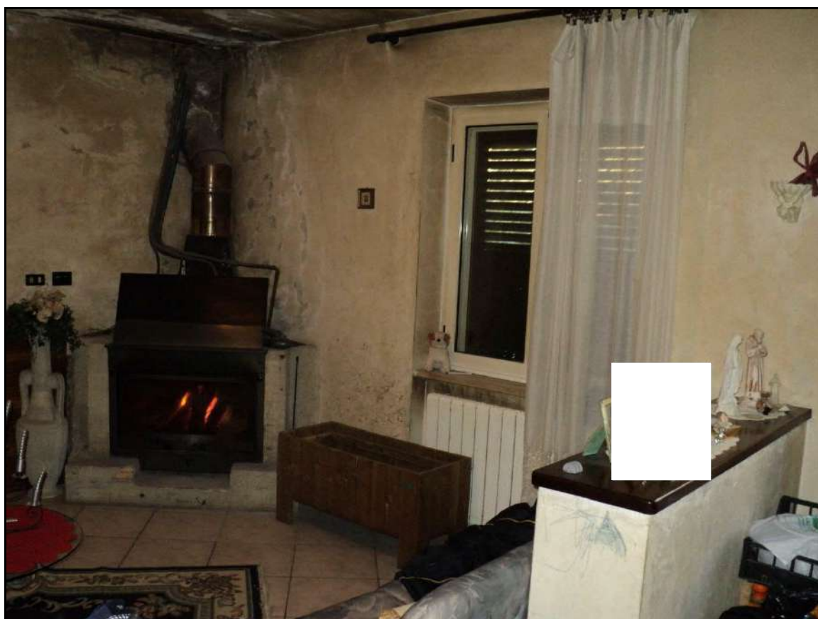
Foto NN° 6,7 – Soggiorno con termocamino ed evidenti tracce di umidità e muffa.
