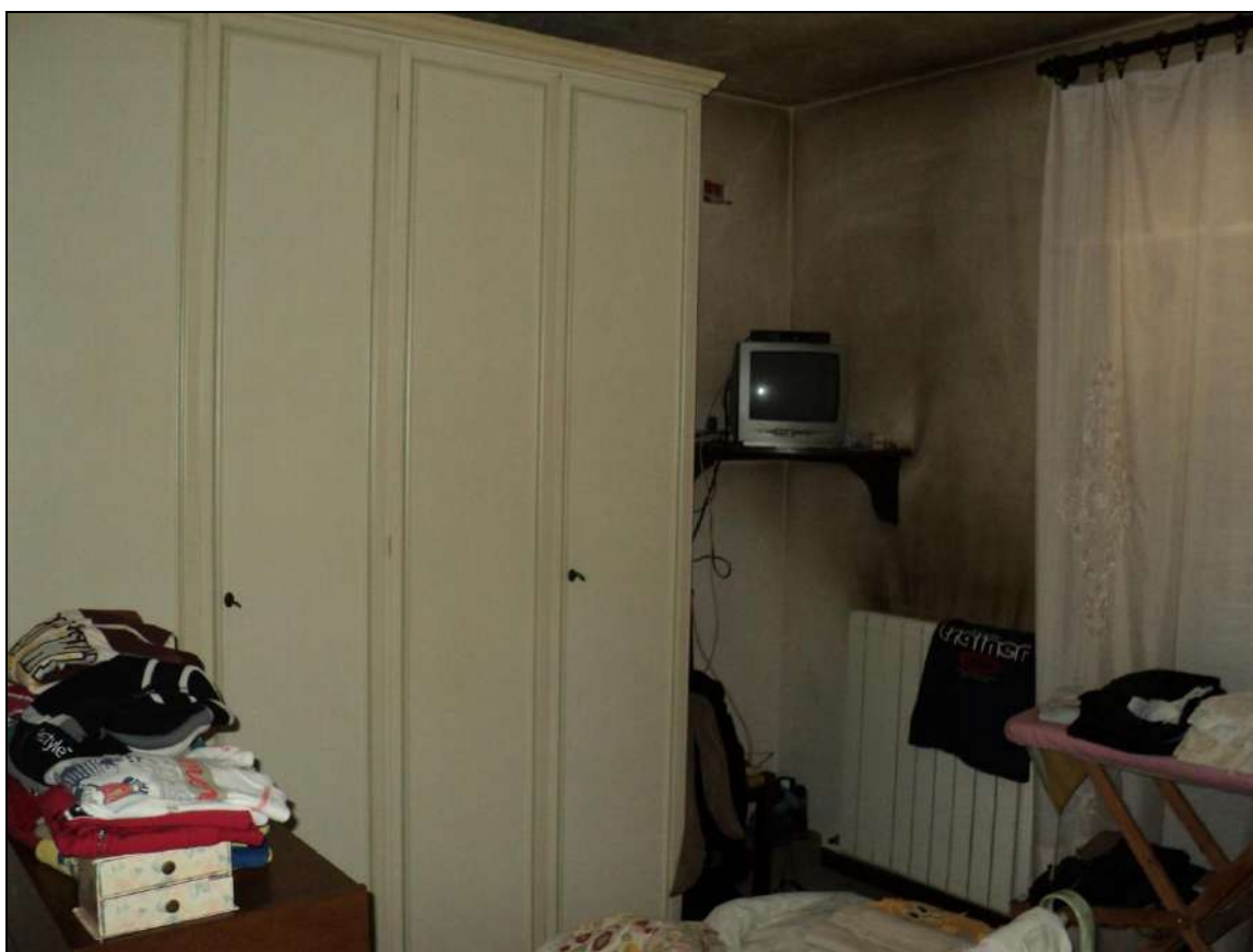
Foto NN° 8,9 – Camera da Letto matrimoniale, con tracce umidità e muffa sul soffitto.
