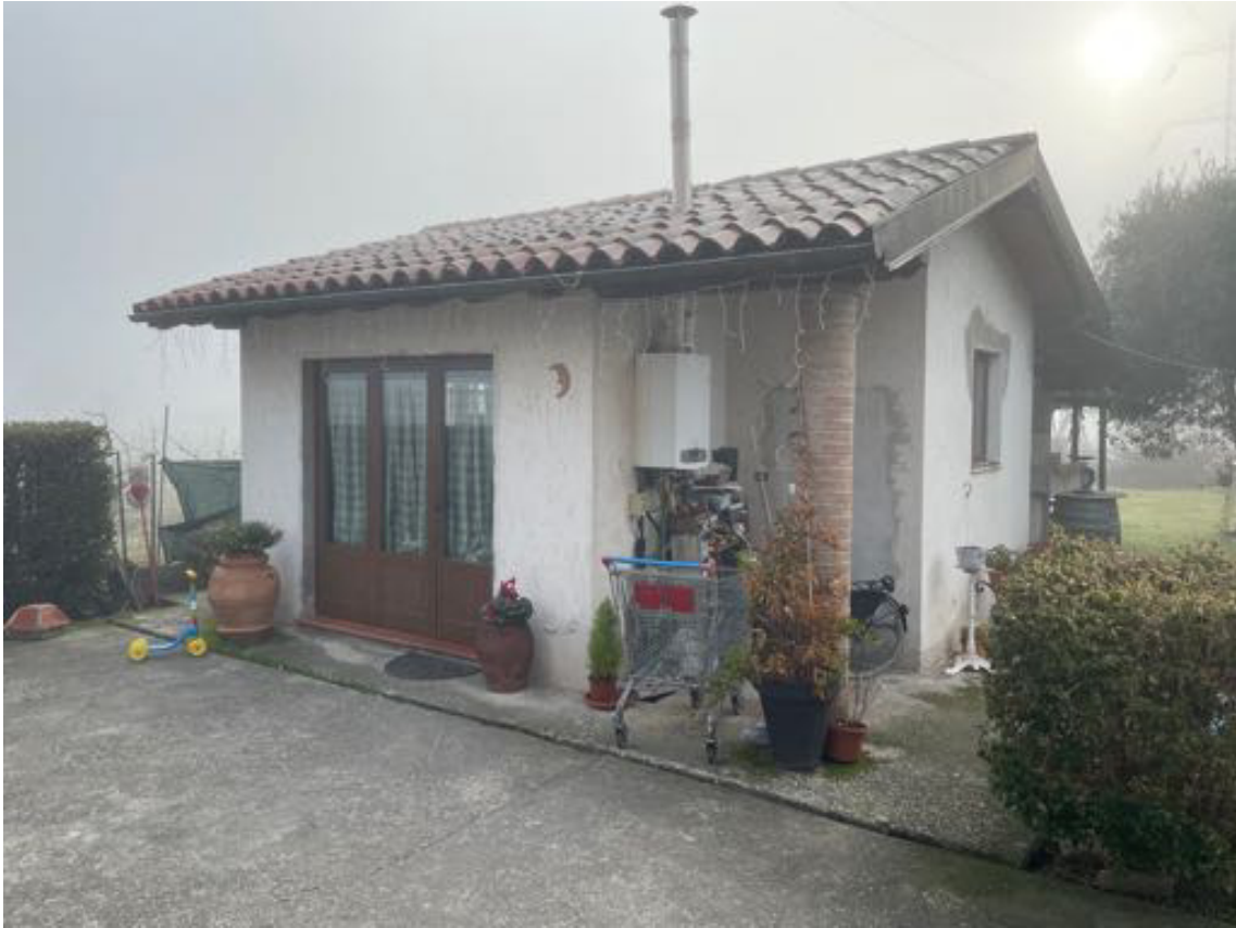
Lotto 2 – foto 15 – Manufatto pertinenziale
