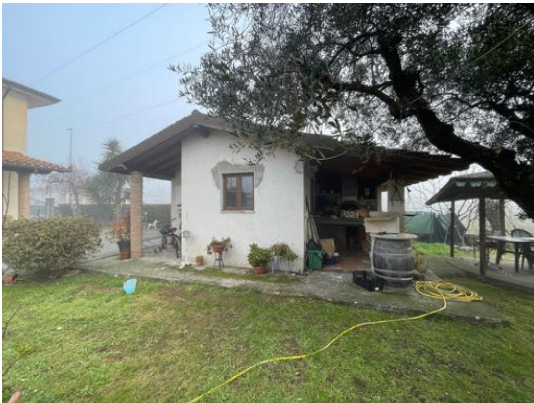
Lotto 2 – foto 14 – Manufatto pertinenziale
