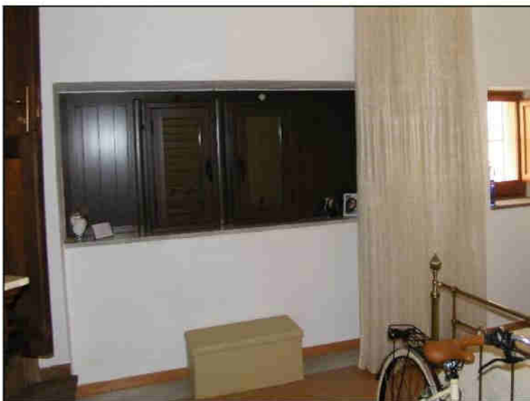
Foto 7. Particolare del portone di ingresso parzialmente murato e modificato in finestra
