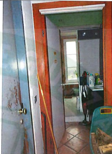
DISIMPEGNO E BAGNO IN CORSO DI COSTRUZIONE
