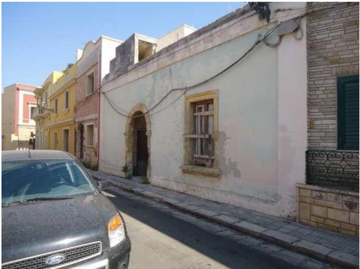
Foto 1 – vista fabbricato da via Dante Alighieri
