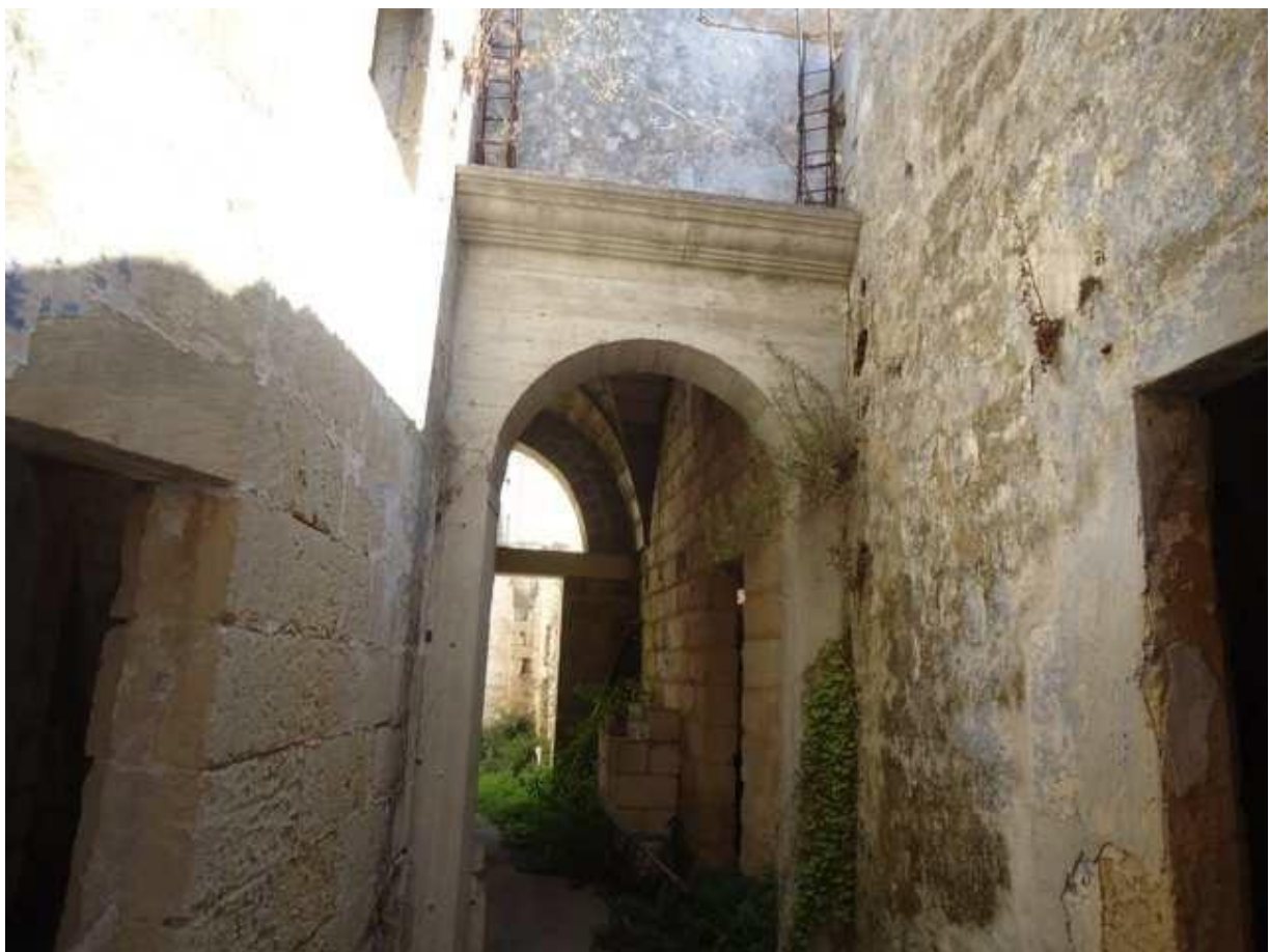
Foto 2 – vista cortile interno ingresso
