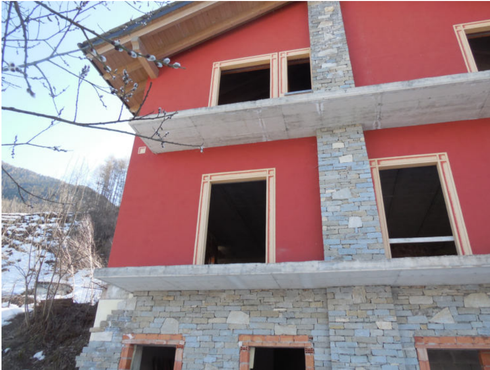
foto n. 10 particolare rivestimento termico a cappotto facciate
