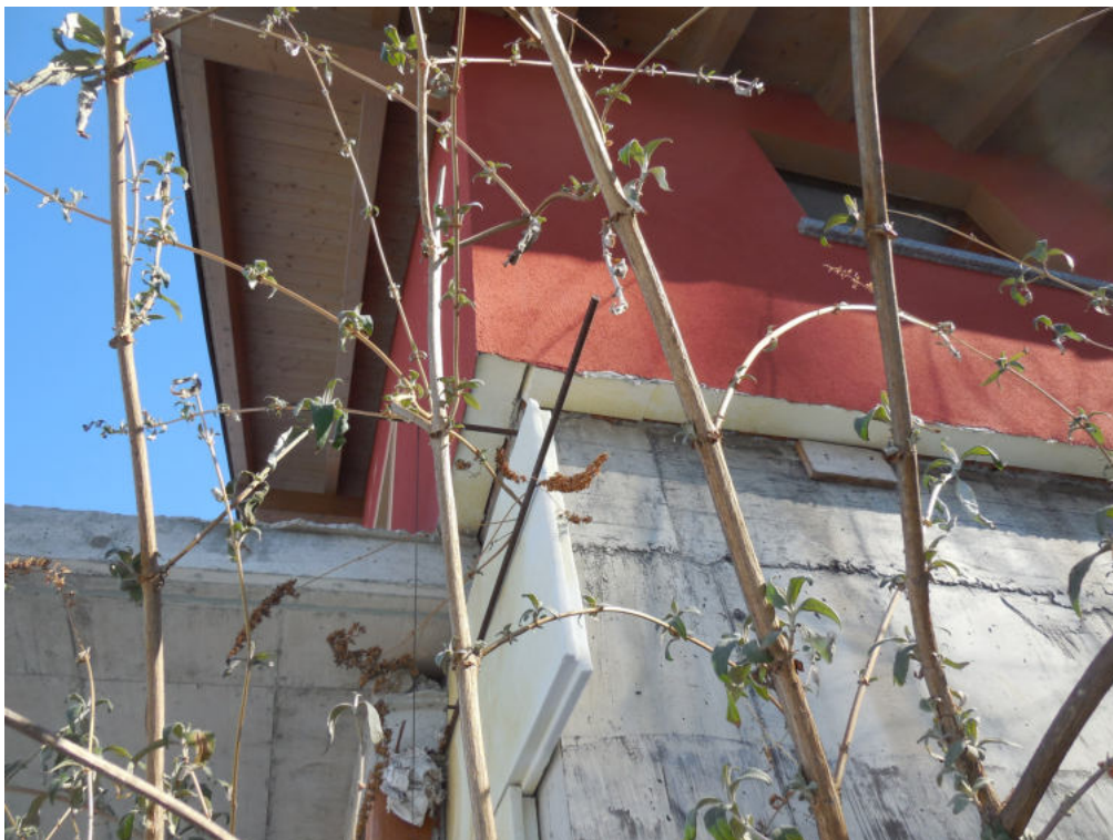
foto n. 10 particolare rivestimento termico a cappotto facciate
