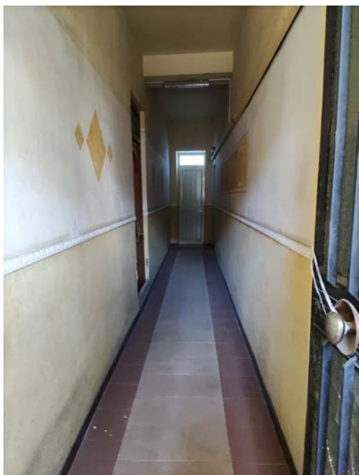
Corridoio comune al piano terra
