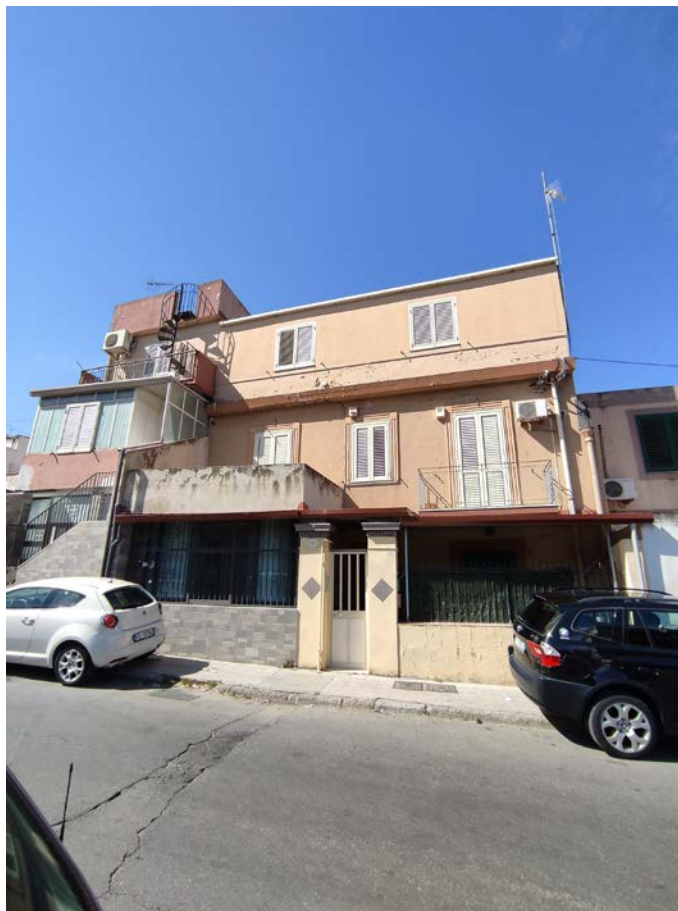
Accesso al fabbricato al piano terra dalla Via Comunale
