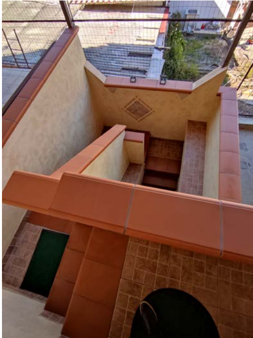
Scala di accesso al 1° piano
