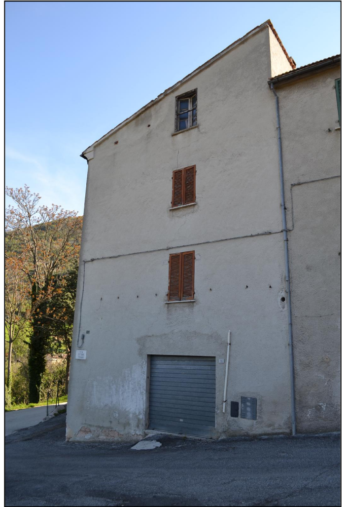
Vista Prospetto Sud-Ovest
