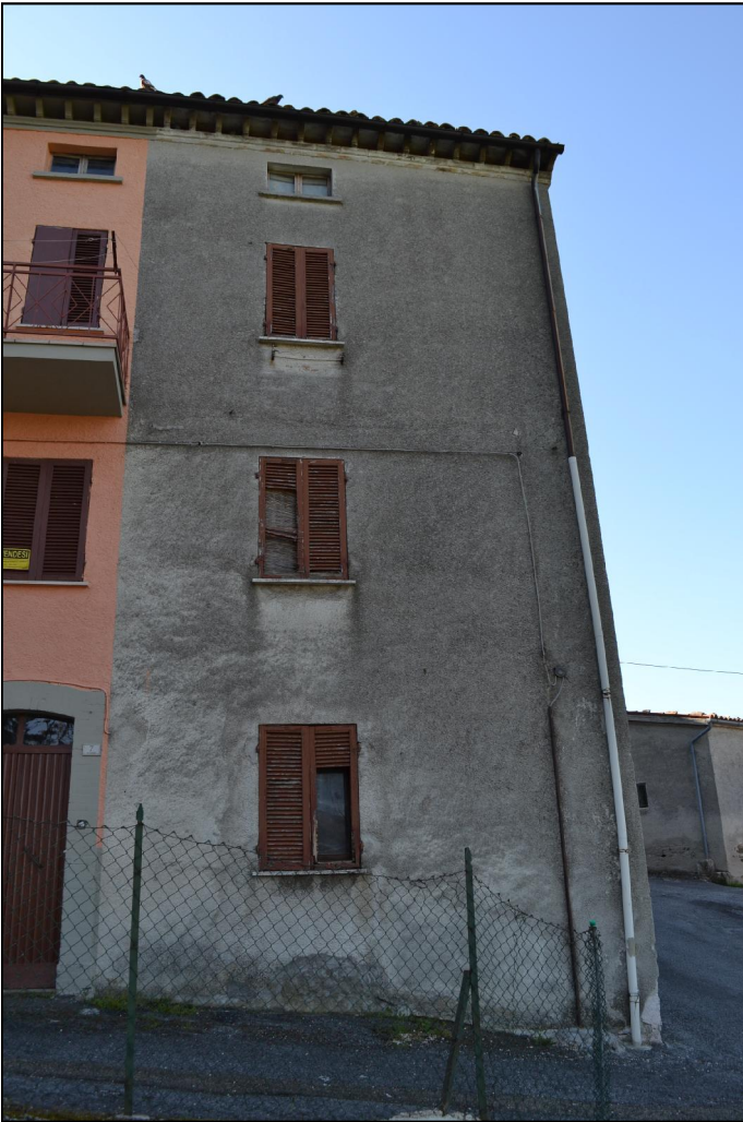
Vista Prospetto Nord-Ovest
