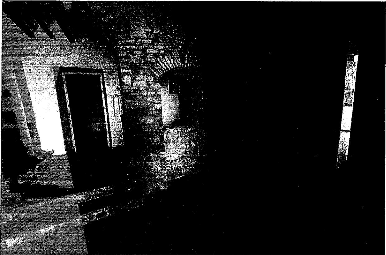
Nell'unità immobiliare sono presenti numerose tracce di umidità, sia da risalita che da infiltrazione, che danneggiano visibilmente le pareti.
