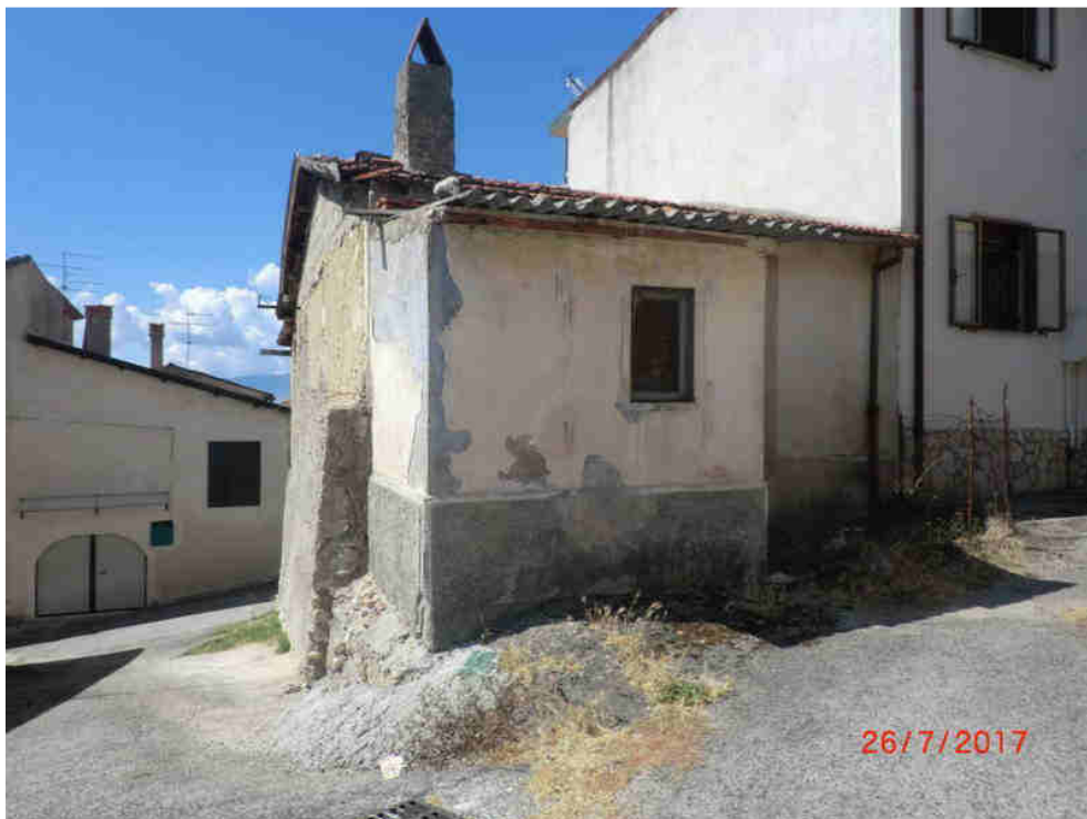
Fotografia n. 2 – Prospetto su via della Chiesa
