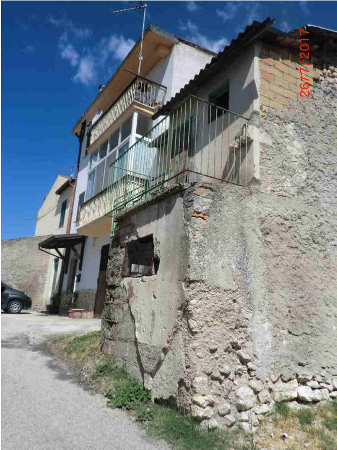
Fotografia n. 5 – Prospetto secondario: ripostiglio e balconcino
