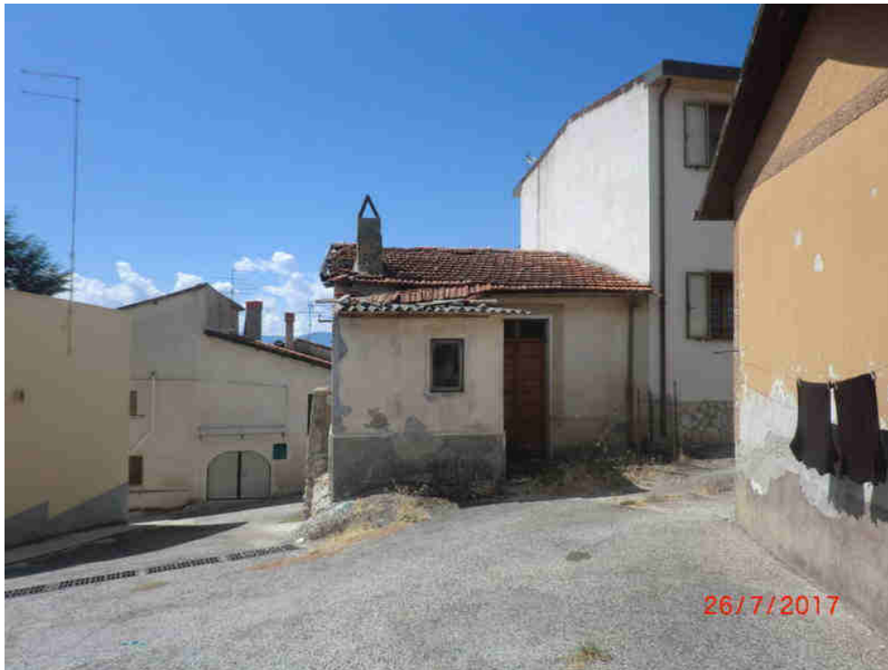
Fotografia n. 1 – Prospetto su via della Chiesa
