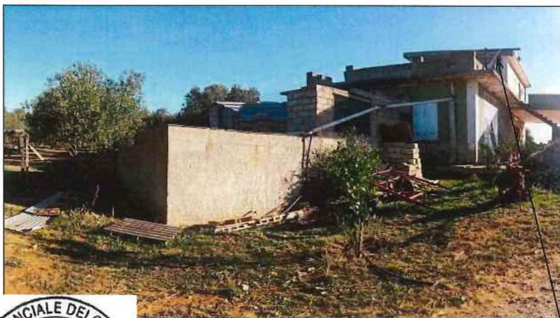
Fabbricato: part.IIa 290 sub.1 (prospetto ovest)
