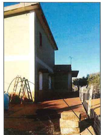
Fabbricato: part.IIa 290 sub.1 (prospetto nord)
