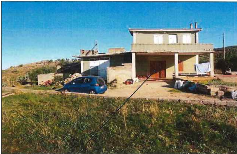
Fabbricato: part.IIa 290 (prospetto sud)
