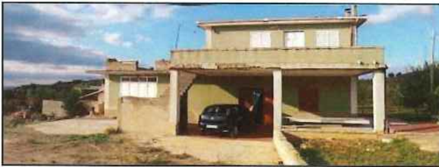
Vista esterna del Fabbricato: part.IIa 290 (prospetto sud)
